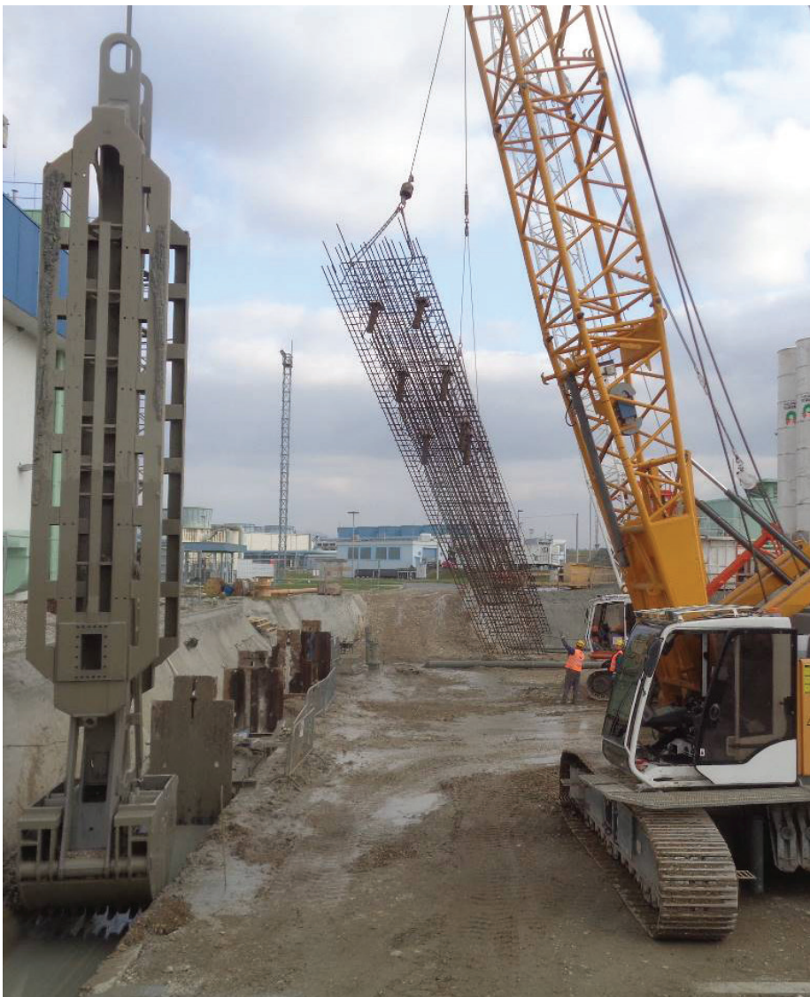
Slika 5 • Izkop za diafragma in vgradnja armaturnega koša.
