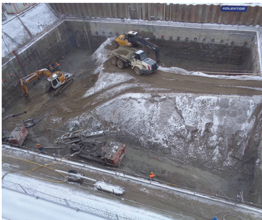
Slika 7 • Izkop in vgradnja sider.
