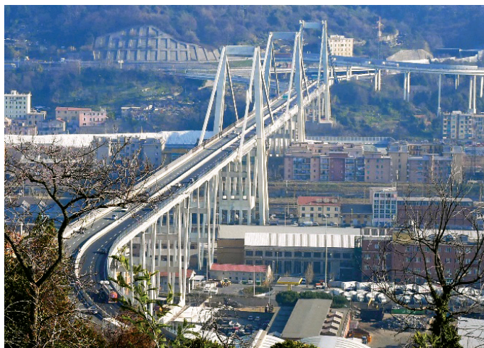
Slika 1 • Natezno obremenjene armiranobetonske vešalke na mostu čez Savo Dolinko v Kranjski Gori (Martuljski slapovi, 2018) (levo) in prednapete betonske vešalke na starem mostu Ponte Morandi v Italiji (Ponte Morandi, 2020) (desno).
