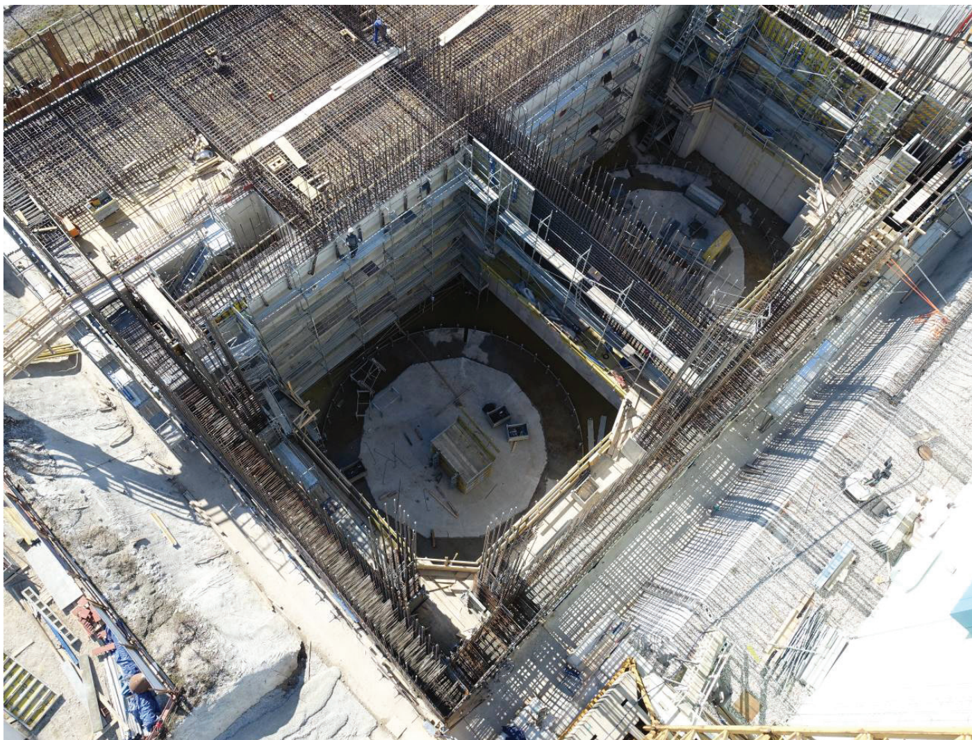
Slika 9 • Gradnja sten etaže P.
