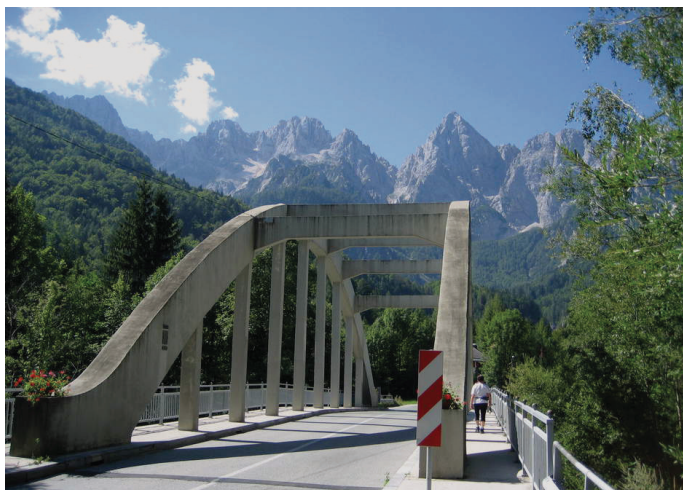
Slika 1 • Natezno obremenjene armiranobetonske vešalke na mostu čez Savo Dolinko v Kranjski Gori (Martuljski slapovi, 2018) (levo) in prednapete betonske vešalke na starem mostu Ponte Morandi v Italiji (Ponte Morandi, 2020) (desno).
