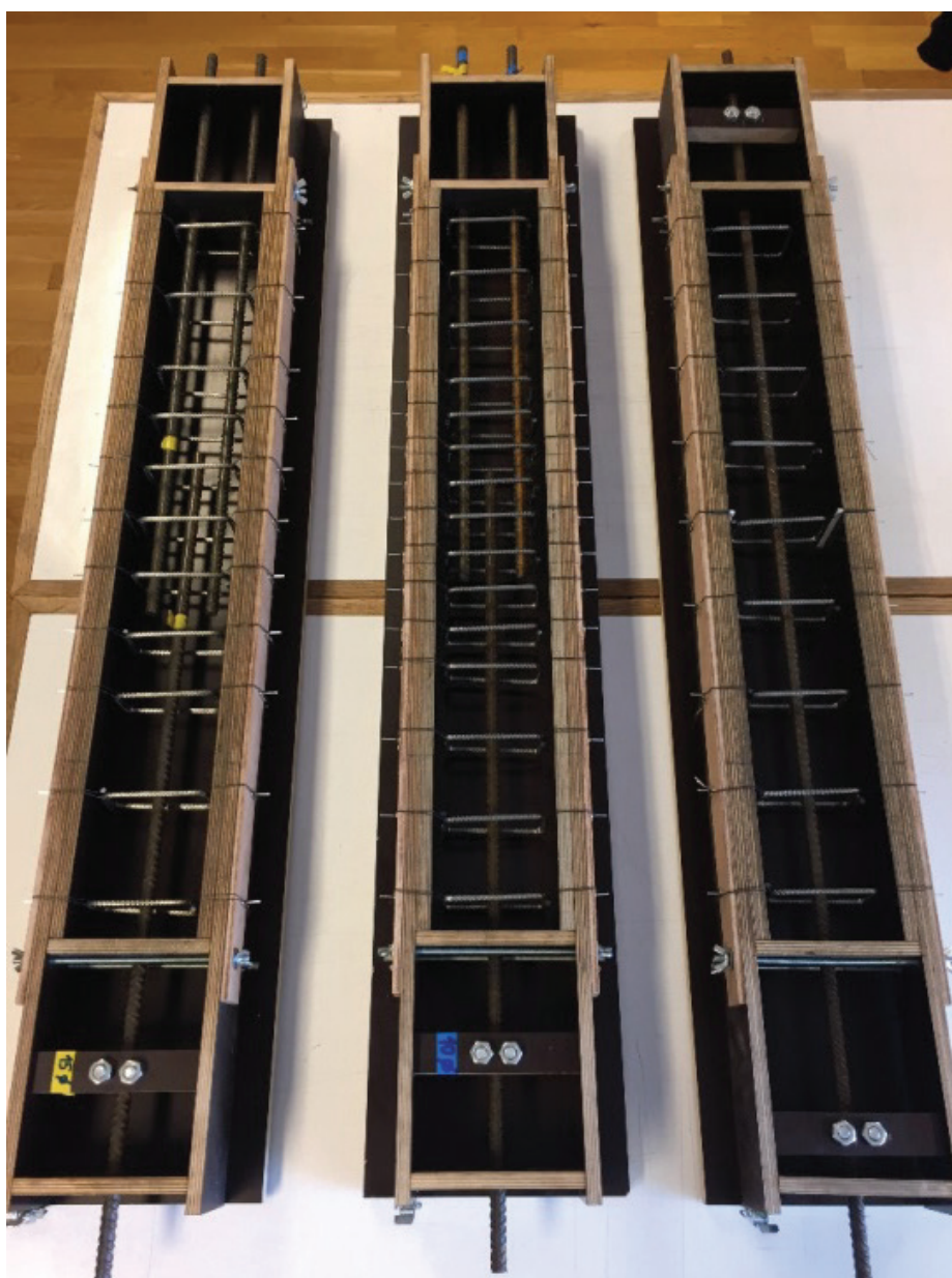
Slika 7 • Leseni kalupi z vgrajeno vzdolžno in stremensko armaturo.
