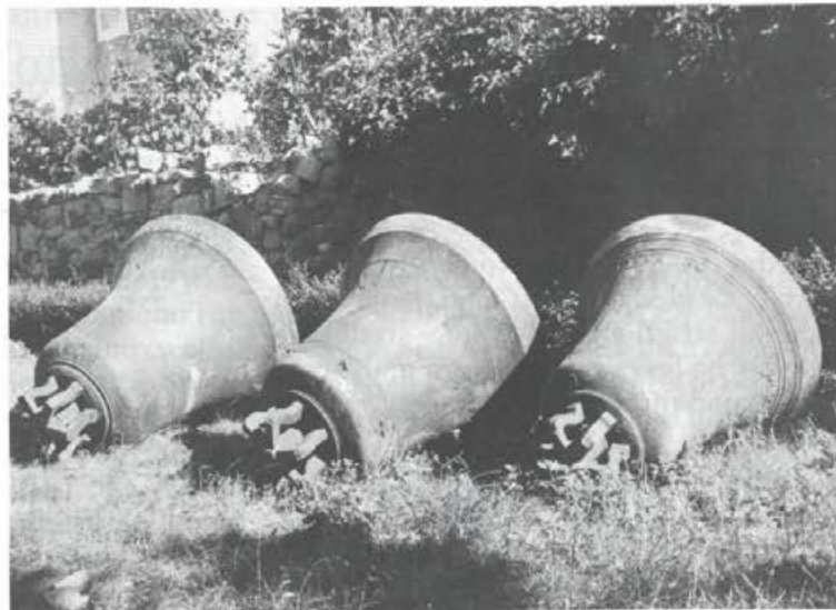
Svetokriški zvonovi na tleh pred cerkvijo med obnovitvijo vrhnjega dela zvonika 1963
