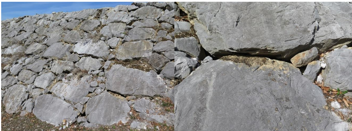
Slika 88: JZ rob odlagališča, spremembe v skalometni peti (foto: RŽV)
