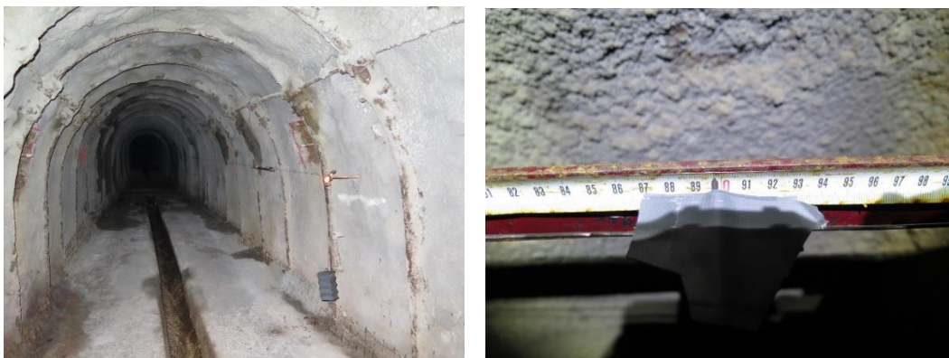
Slika 84: Ekstenziometer na mestu prehoda drenažnega rova skozi drsino plazu (foto: RŽV)
