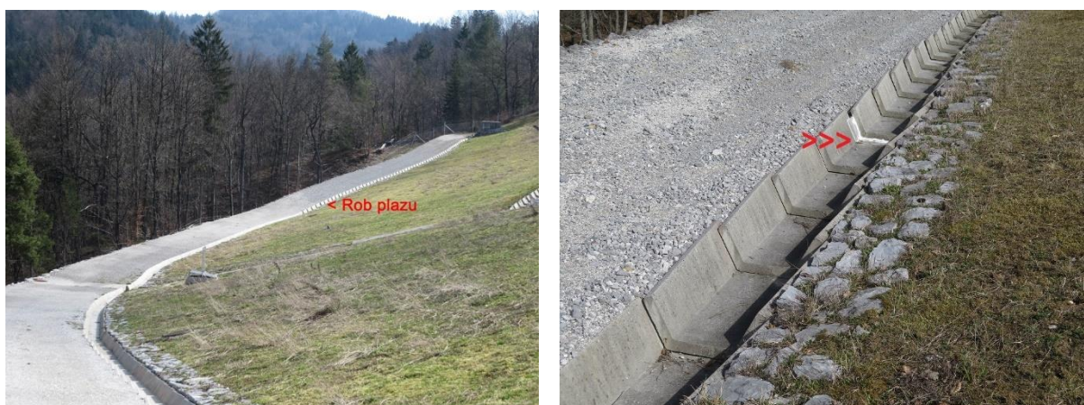
Slika 90: Mesto prehoda roba plazju preko spodnje bermske ceste, mesto razmika (foto: RŽV)
