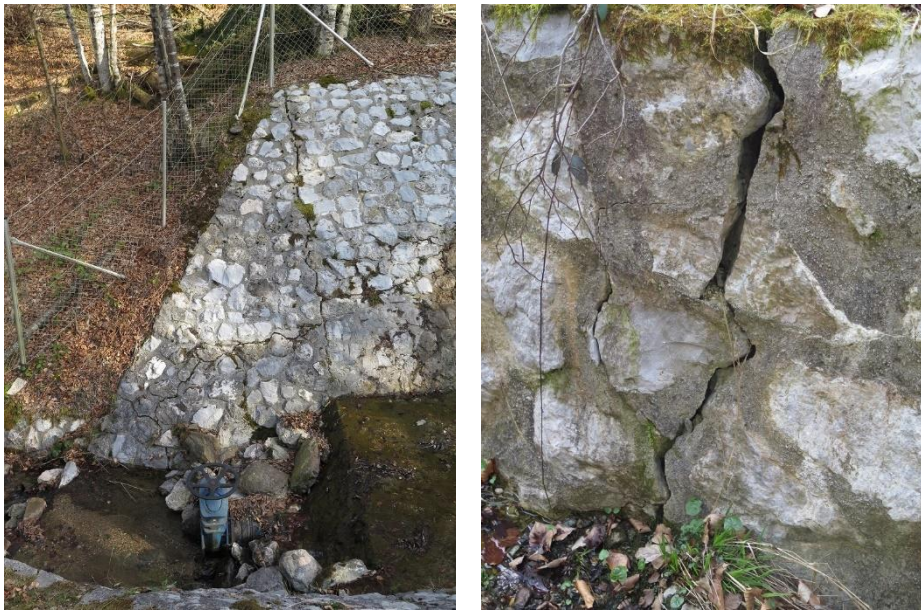
Slika 92: Razpoke na steni ob MM BPG, ena izmed razpok v odvodnem kanalu pod MM BPG (foto: RŽV)
