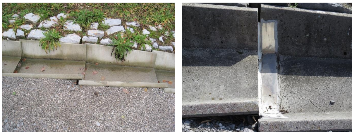
Slika 91: Stanje kanalet leta 2012 (prekritje kanalet še 4 cm) in konec leta 2019 (ni prekritja) (Foto: RŽV)
