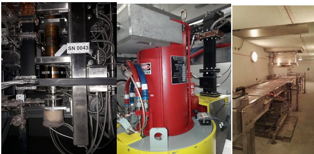
Slika 101: Slika linearne pospeševalnika delcev (levo), Klystrona (sredina) in prostor t.i. bunkerja z linearnim pospeševalnikom (slika desno - Foto ZVD d. o. o.)
