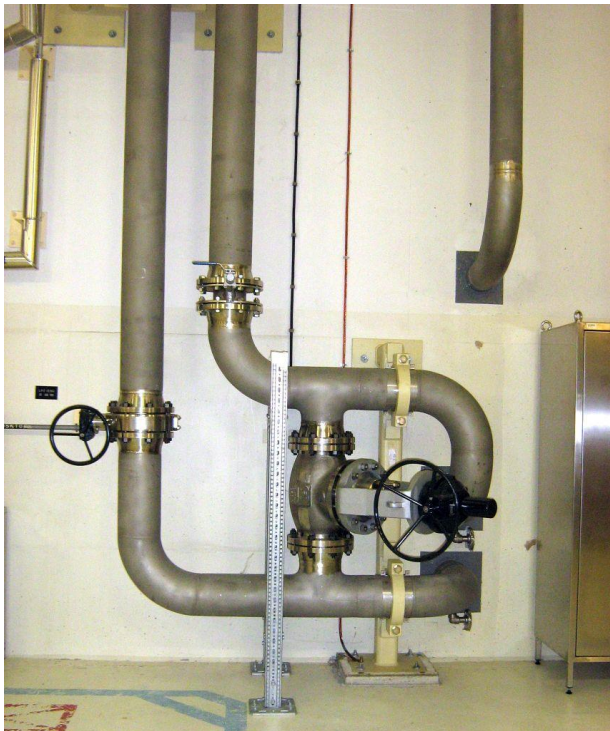
Slika 67: Cevovod sistema alternativnega hlajenja bazena z izrabljenim gorivom (Foto: inšpekcija URSJV)
