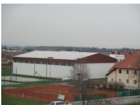
Energetska sanacija - športna dvorana Velika Nedelja
