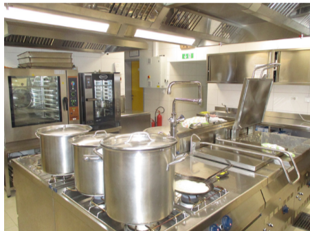
Obnova kuhinje v OŠ Ormož
