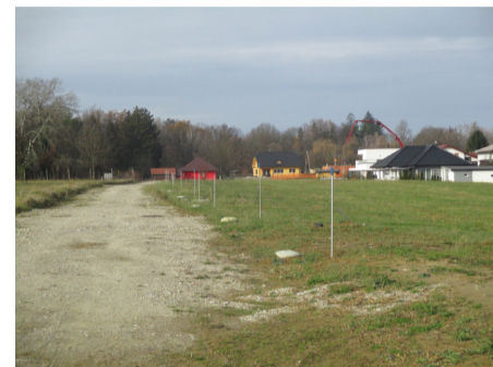
Izgradnja vodovoda pri vinski kleti
