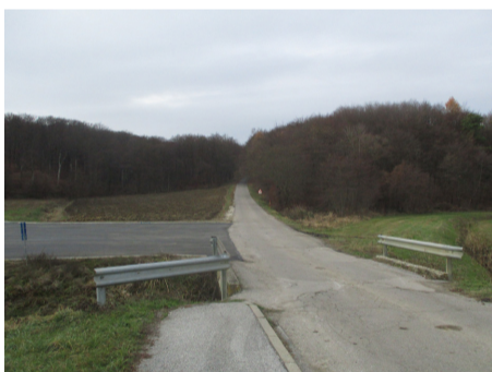
Izgradnja vodovoda Miklavž
