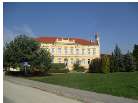
OŠ Ormož – energetska sanacija
