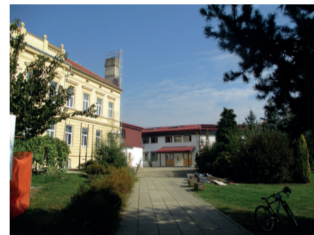
OŠ Ormož - energetska sanacija
