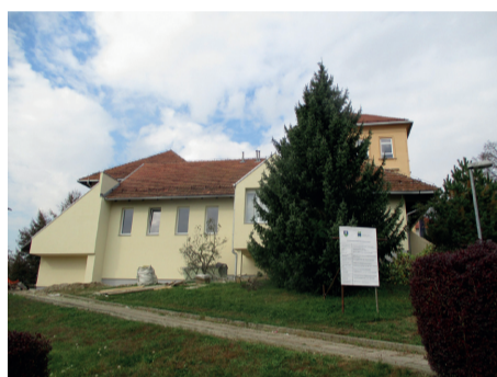
OŠ Velika Nedelja - energetska sanacija
