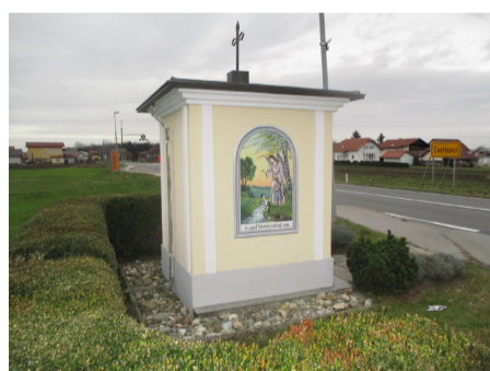
Obnova kapele - Cvetkovci
