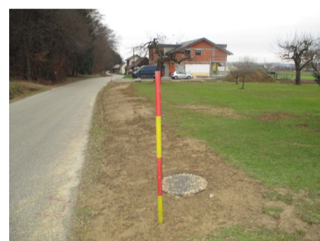
Izgradnja kanalizacije in pločnika v Podgorcih
