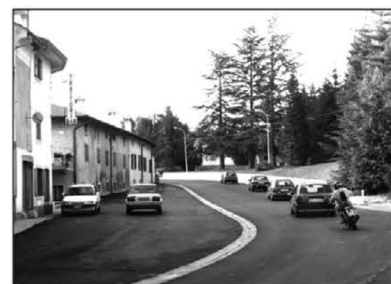
Tratto della strada statale 54
