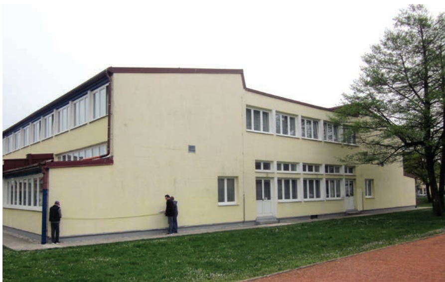
Izvajanje meritev z običajnim metrom in laserskim merilnikom
