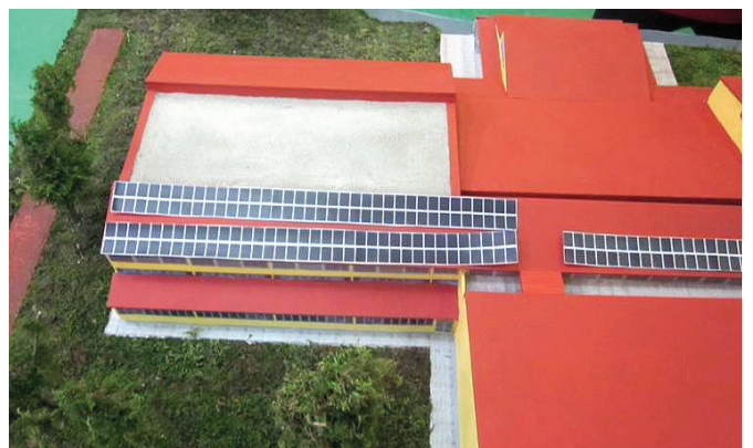
Zaradi boljše predstave ob morebitnem gradbenem posegu smo na streho namestili še nekaj modulov sončne elektrarne.
