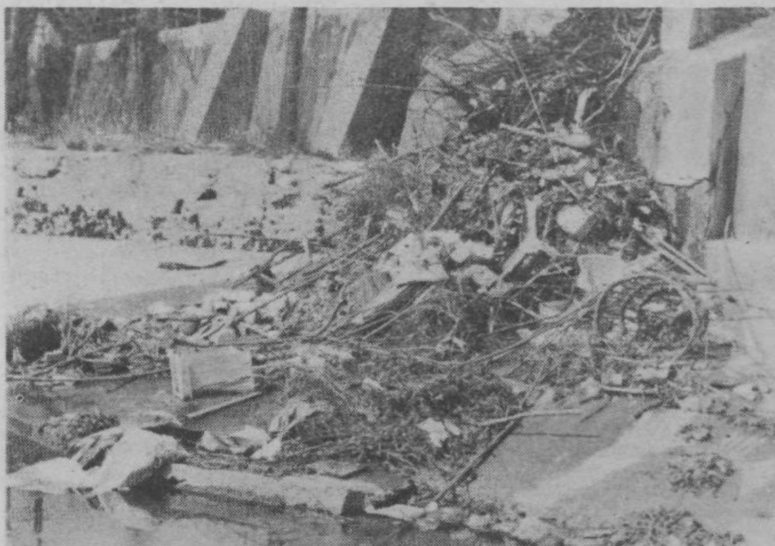
Pod jezom Ljubljane na Vevčah se je nabralo že toliko smeti in raznih odpadkov, da v poletnem času močno zasmrajajo okolico. Sanitarni inšpektorji, kje ste?
