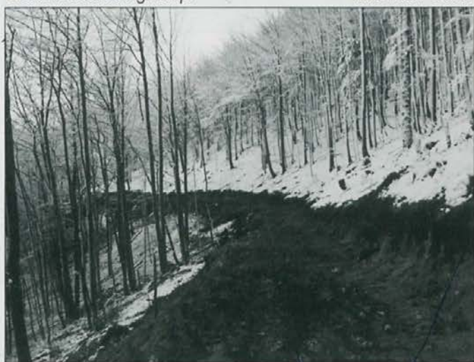
Cesta v začetku izgradnje
