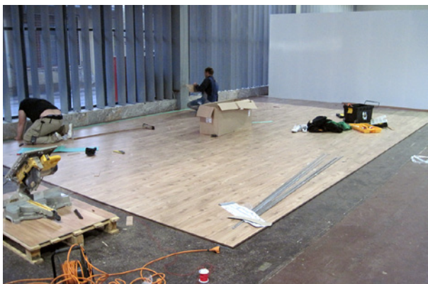
Slika 1. Polaganje talne obloge je bilo temelj za nadaljnje delo (foto: B. Kričej)
