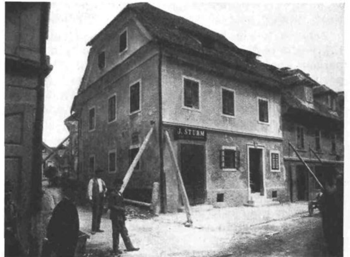
Vhod v Kolodvorsko ulico iz Šentpeterske ceste. Desna stran je zaradi razširjenja podrtá
