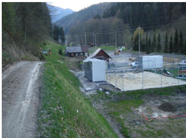
Pogled na gradbišče
