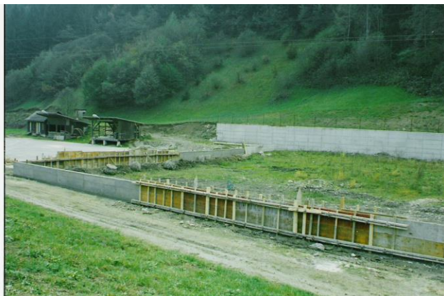
Okrog teniških igrišč smo zabetonirali metrski oporni zid
