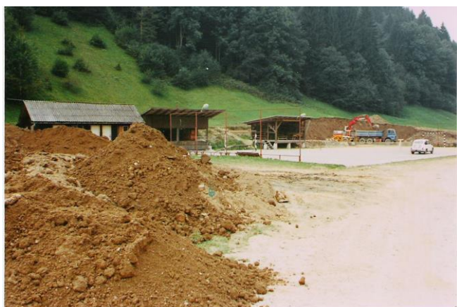
Izkop zemlje za tenis igrišče
