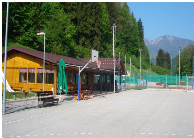
Zunanji izgled gostinskega objekta
