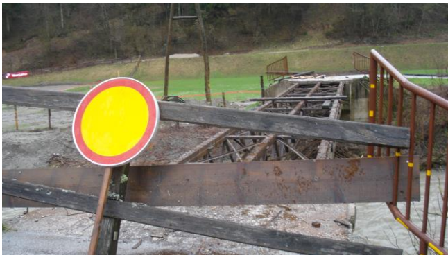
Obnova mostu čez Soro na Rovn
