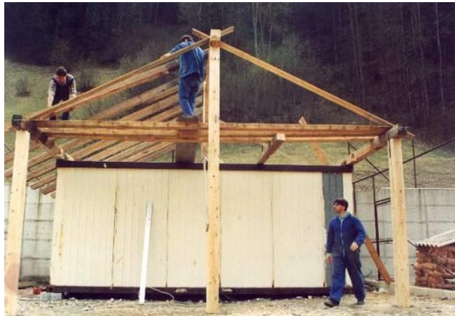
Nastaja streha nad kontejnerjem
