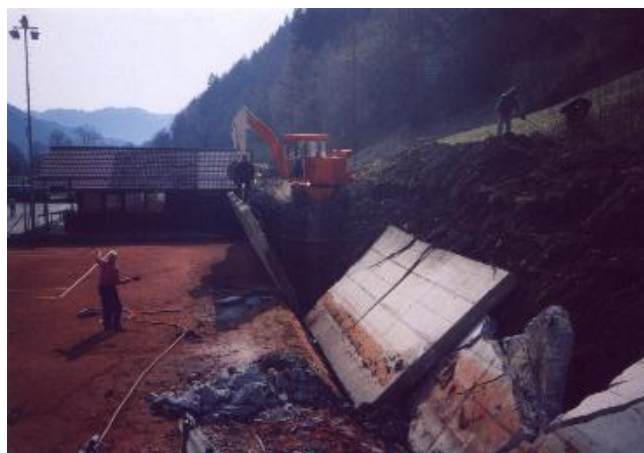
Sanacija opornega zidu na igriščih za tenis
