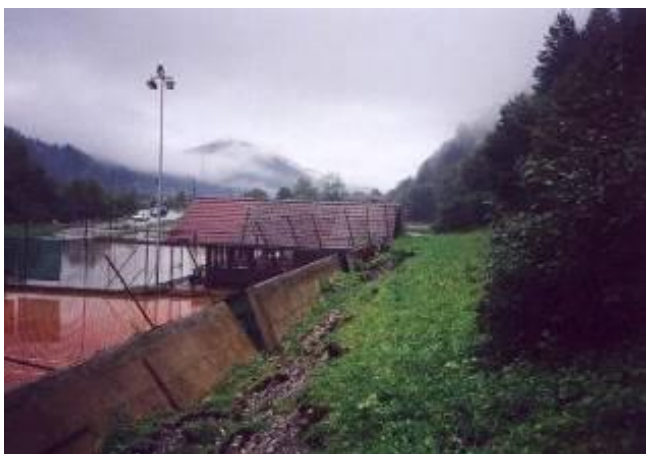
Opustošenje po poplavi – padel oporni zid pri tenis igrišču
