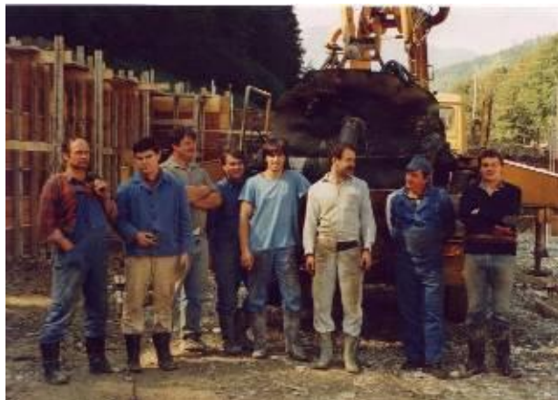
Delovna akcija: izdelava betonskega opornega zidu
