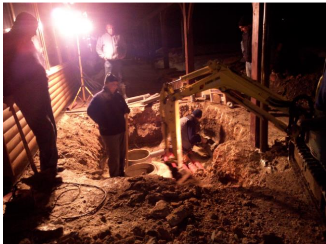
Vgradnja čistilne naprave
