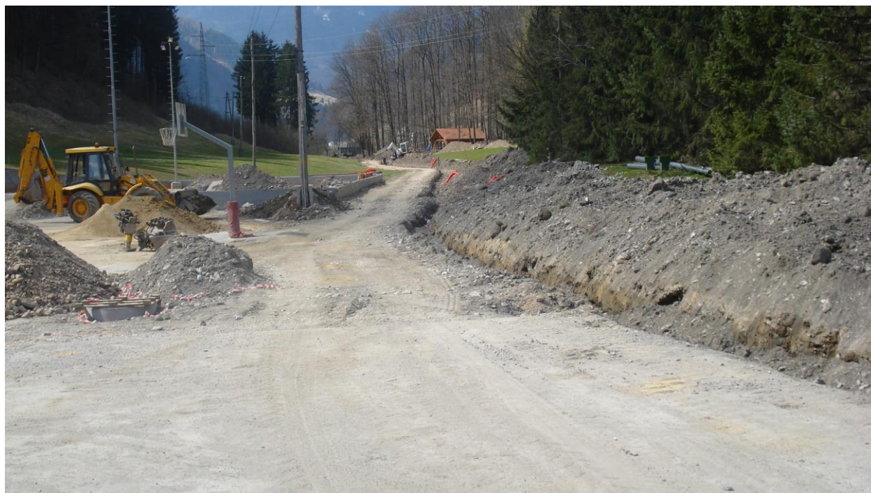
Napeljava elektrike, vode, kanalizacije čez cel park Rovn
