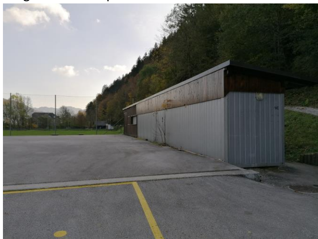
nova streha nad sanitarnim in skladiščnim kontejnerjem
