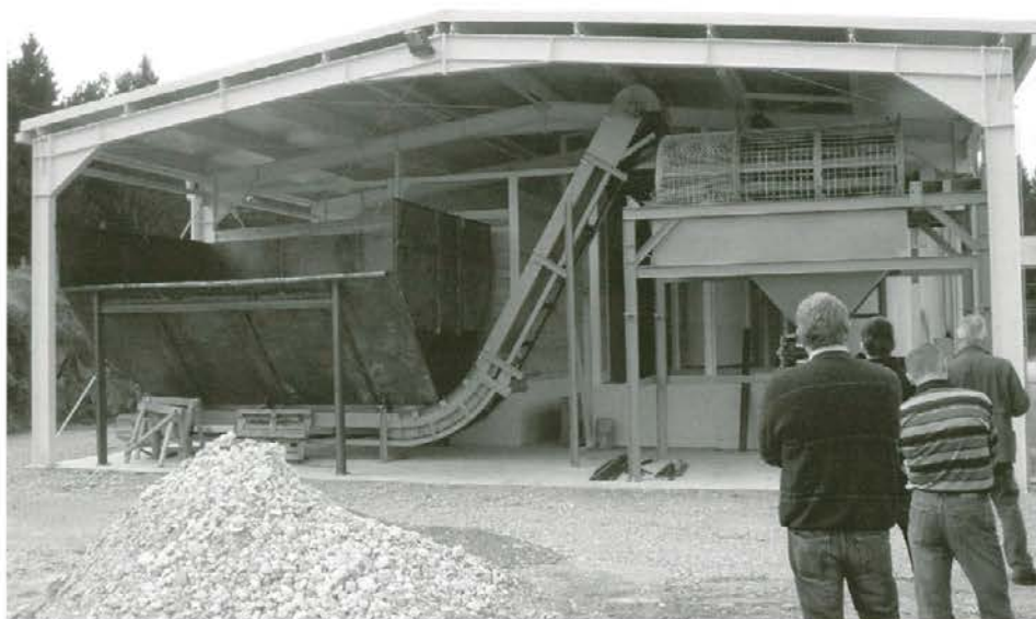
Ogled obrata za proizvodnjo električne in toplotne energije
