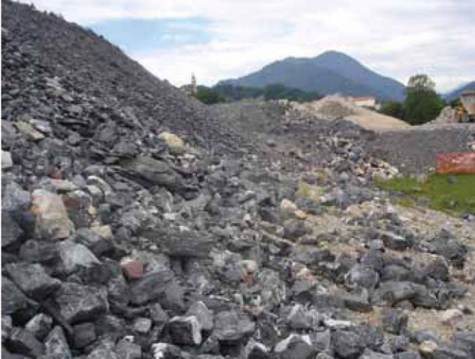
Odvaj materiala, izkopanega v predoru Pod Stenom v juniju leta 2012. Na tem delu je v glavnem črni apnec, prepreden s kalcitovimi žilami. Foto: Vili Rakovec.
