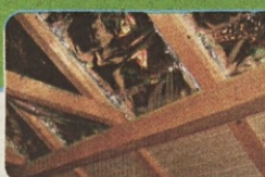
Polaganje izolacijske folije SuperFOIL med škarnike, tako da so ti po podeskanju vidni.
