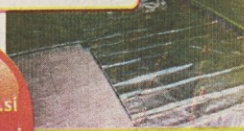
Polaganje tanke izolacije SuperFOIL neposredno na obstoječo neizolirano ploščico.
