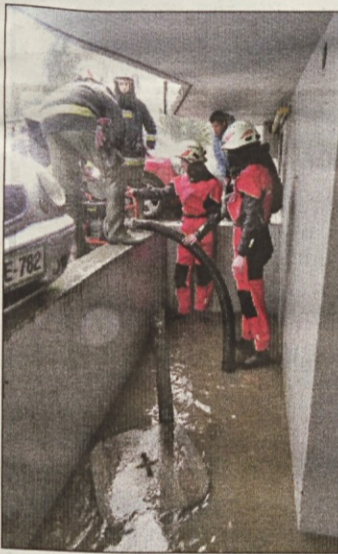
Gasilci črpajo vodo iz stanovanjskega bloka v Prešernovi v Ilirski Bistrici
