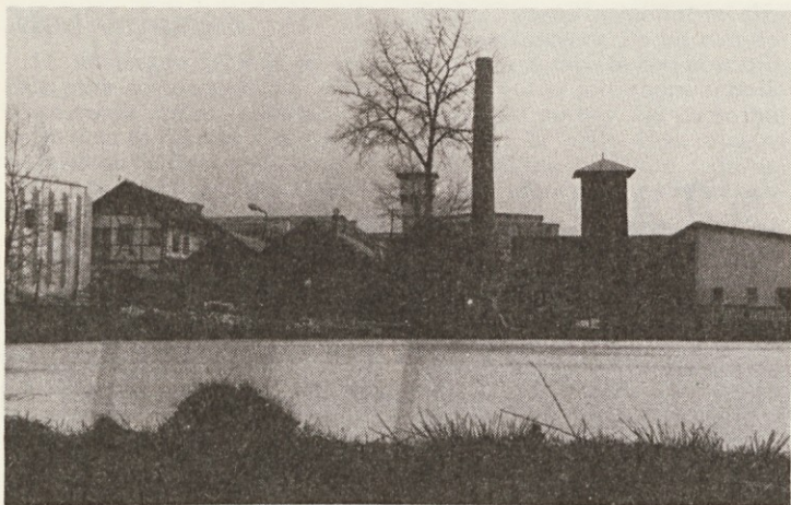
Bajer, ribnik z vodo za primer požara se bo v prihodnosti umaknil skladišču. Voda za gašenje požarov pa bo v manjšem, toda v globljem vodnem zbiralniku.
