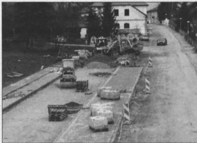
Dela na ulici Pod obzidjem
