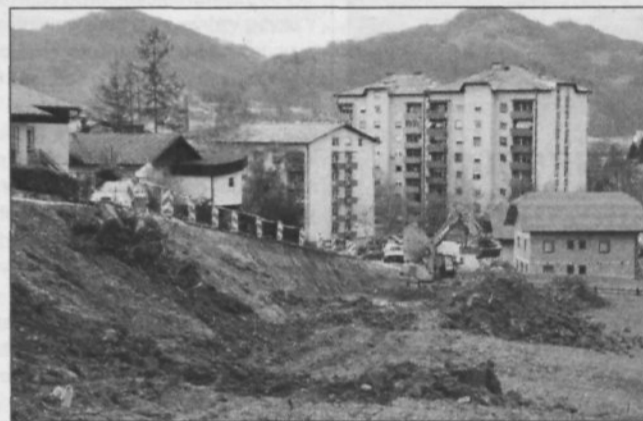
Obnova ceste na Grič (foto: Vili Zupančič)
