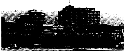
Zgradba hotela Metropol je veljala (enako kot portoroški Avditorij) v času izgradnje v 70-ih letih 20. stoletja, za vrhunski dosežek tedanje arhitekture.
