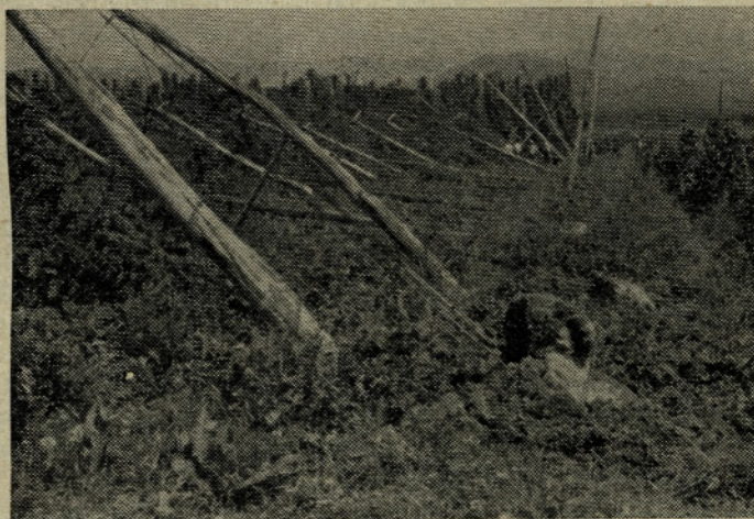
Delno dvignjena žičnica. Ob rušenju so se sidra izpulila iz zemlje
