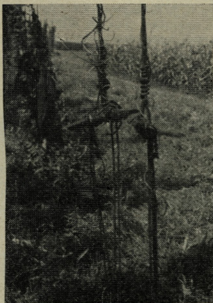
Malomarno navita žica na napenjalnih klinih je tudi lahko vzrok zrušitve žičnice
