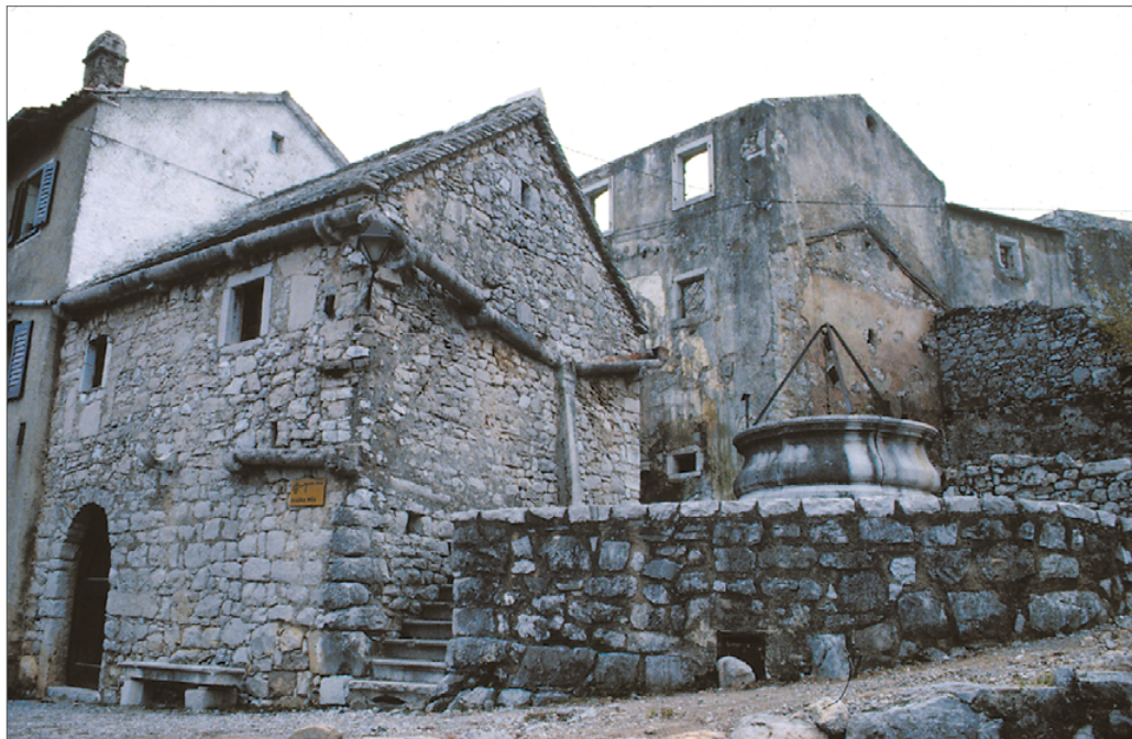
Slika 26. Človek in voda na Krasu: zajemanje deževnice s kamnite strehe (foto: arhiv KGS).
