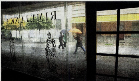
Nekaj ugleden poslovni objekt propada pred očmi meščanov.
