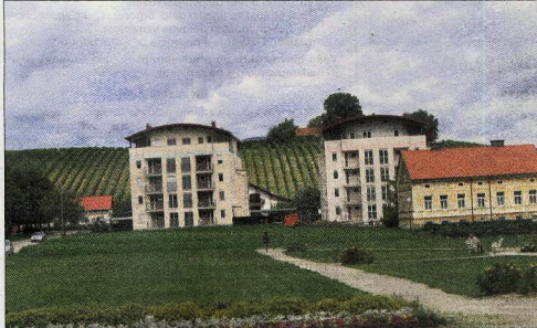
Na Slomškovi so zaključili gradnjo drugega bloka z 18 stanovanji in so pripravljali na gradnjo tretjega.
