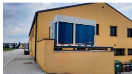
Rekonstrukcija kotlovnice v vrtcu Ormož
