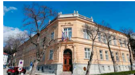
Energetska sanacija stavbe Občine Ormož z UE Ormož
