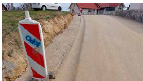
Rekonstrukcija vodovoda DN 110 Strjanci 31-Bresnica 85
