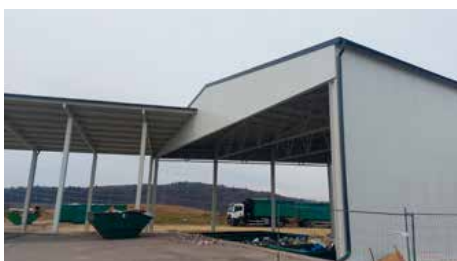
Nadgradnja zbirnega centra Dobrava
