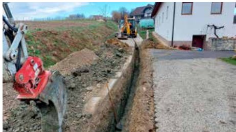
Rekonstrukcija cevovoda v Pavlovskem vrhu HŠ 52-58, gradnja meteorne kanalizacije
