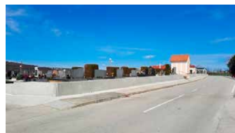
Ureditev opornega zidu in ograje pri pokopališču Ormož
