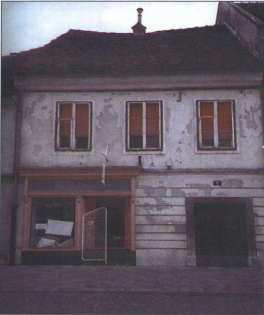
Slika 3: Neurejena pročelja hiš kazijo videz celotne ulice. Hiša na fotografiji je v celoti zapuščena. Lastnik lokala se je odpravil iskat srečo v Ljubljano, zaprta okna s spuščeni zavesami pa kažejo tudi na zapuščeno zgornje nadstropje. Streha se je že delno vgreznila in je potrebna temeljite prenove. (Foto: Ž. Ramšak.)
