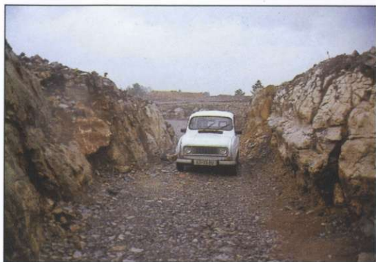
Slika 4: Pogled na Brezstropo jamo pri Povirju potem, ko so ji že začeli nasipati in utrjevati dno. Na stenah rova so vidni žlebovi, v levem delu slike pred avtomobilom pa tudi ostanek erodirane sigove kope. (Foto: A. Mihevc.)
