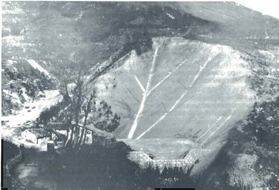
Slika 1b: Spodnji del zlivnega območja Bele ob žagi – po opravljenih ureditvenih delih I. 1935
