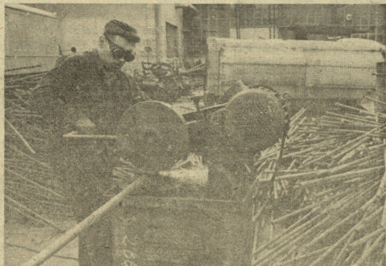
Jože Lipovšek na Strojni postaji reže palice za sidra žičnic, ki jih bomo gradili jeseni
