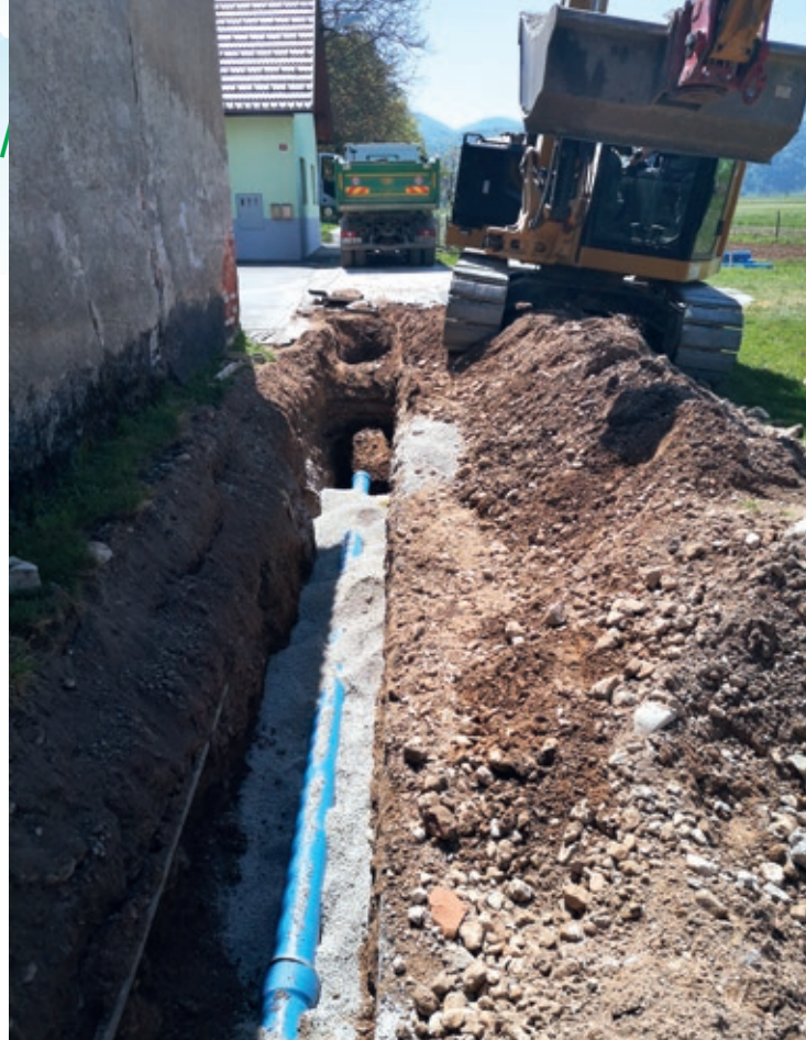
Obnova vodovoda v Stajah
