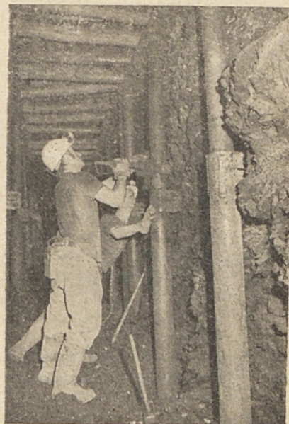
Podpiranje na širokem čelu. Postavljanje železne stojke pod stropnik. Jama Trbovlje.
