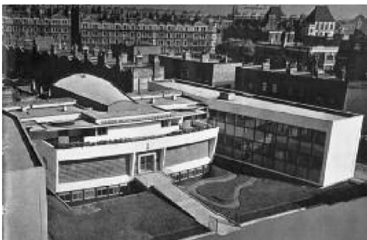
Zdravstveni center Finsbury, obnovljeno krilo
