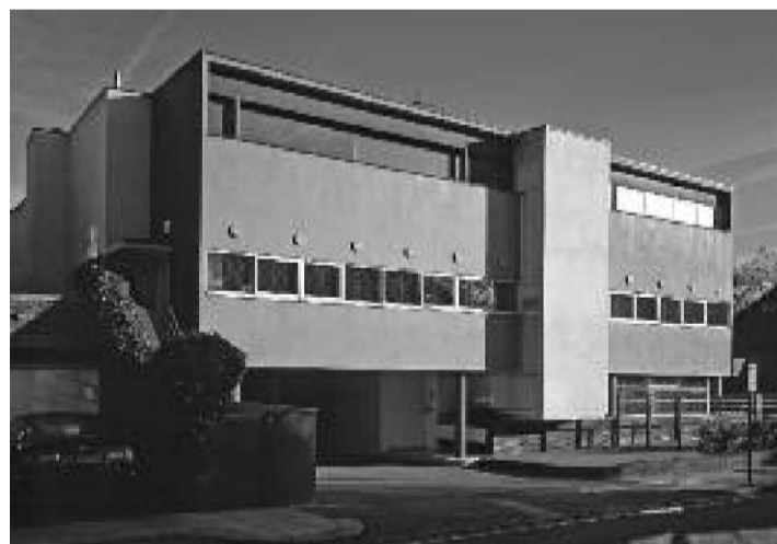
Obnovljeni Fagnal, fasada ob cesti
