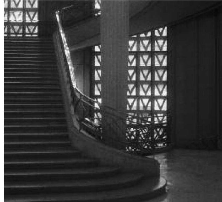
slika 4: Vlito stopnišče in prosojen zid iz betonskih plošč, bivša Maison des travaux Publics, Auguste Perret, Pariz, 1937
