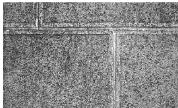
slika 5: Vliti in razrezani betonski bloki, bivša Maison des travaux Publics, Auguste Perret, Pariz, 1937
