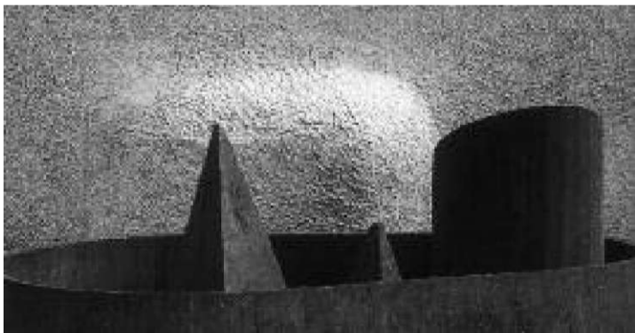
slika 6: Vodni rezervoar iz betona, vlitga s tehniko béton brut , kapela Notre Dame du Haut, Ronchamp, Le Corbusier, 1950
