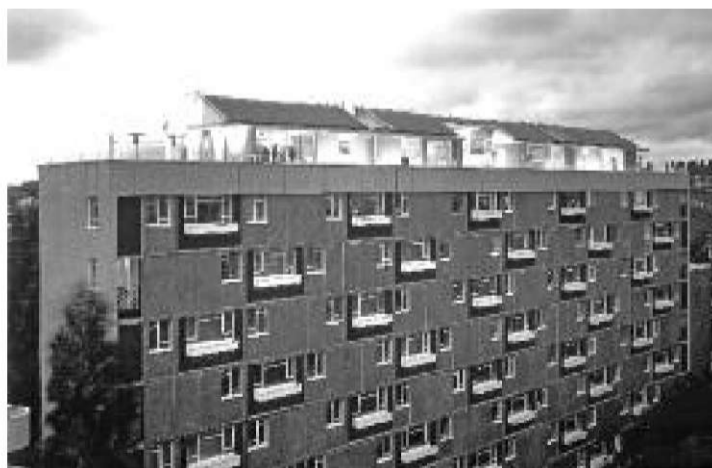
Obnovljena fasada Priory Heights
