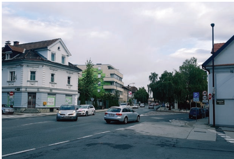
Slika 6: Na levi strani preozek in nevaren kolesarski pas, na desni brez kolesarske površine na zelo prometni Njogoševi cesti v notranjem cestnem obroču (vir: Ljubljanska kolesarska mreža).
