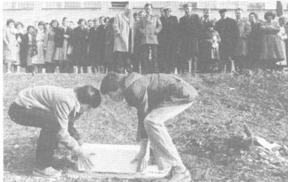
Učenca osnovne šole Vič Gregor Höffler in Borut Krizan sta »zacementirala« temeljni kamen za izgradnjo prizidka Zdravstvenemu domu Vič.
