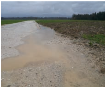
Nasut material povzroča zastajanje vode na cestišču.
