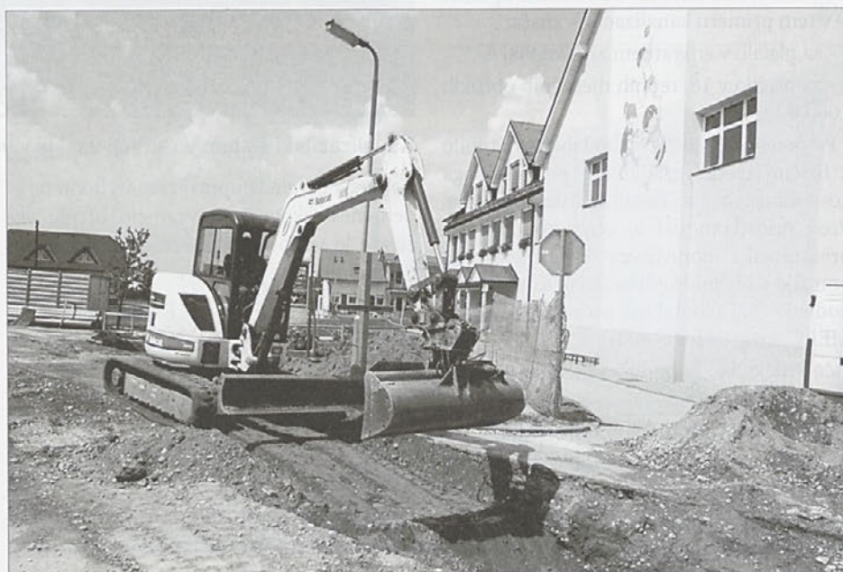
Izgradnja kanalizacije pri OŠ Hajdina
