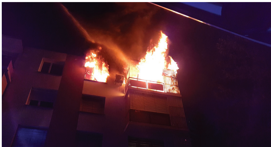
Sliki 1 • Požar v stanovanjskem bloku na Gosposvetski cesti v Mariboru 14. 7. 2020 (vir: Gasilska brigada Maribor).
