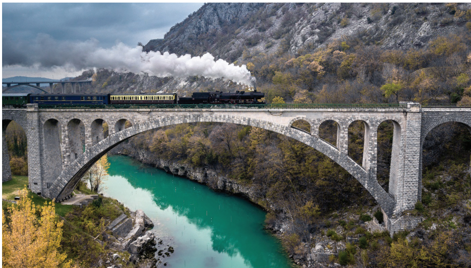
Slika 2 • Solkanski železniški most čez Sočo iz leta 1906 ima največji lok med kamnitimi mostovi na svetu. Razpon loka znaša 85 metrov. Foto: Simon Monfardini
