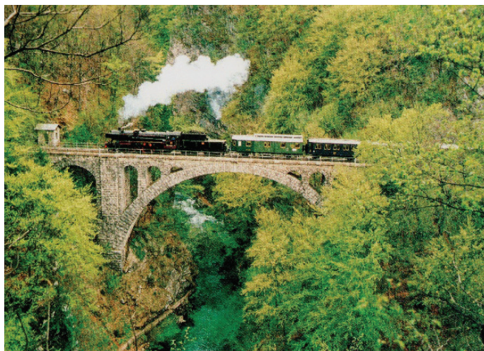
Slika 8 • Železniški most v Blejskem vintgarju na Bohinjski železnici ima kamniti lok z razponom 41 m. Zgrajen leta 1905. Foto: Cesare Quaiat
