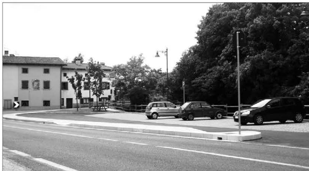
In consiglio si è parlato anche dei lavori realizzati di recente a Ponte S. Quirino
