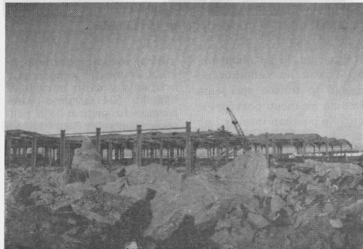
Da je teren tako skalnat se je pokazalo šele pri izkopu.
