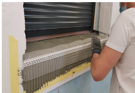
Slika 3 • Vgradnja okenske police – JUB.
