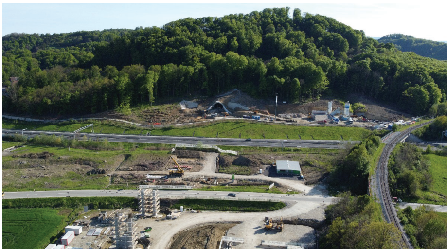
Slika 1 • Severni portal predora Pekel, avtocesta A1, regionalna cesta, obstoječa železniška proga, viadukt Pesnica – stebri v osi 6 in 7, maj 2021.
