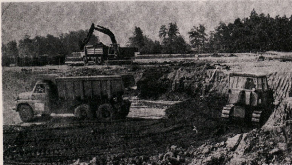
Na gradbišču »Petrol« v Trnovljah pri Celju izvajamo obsežne zemeljske izkope
