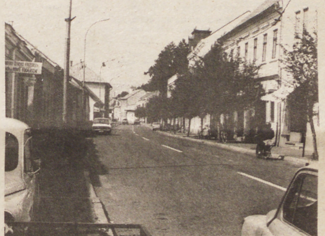
Glavna ulica v Lendavi je bila nekoč ponos mesta. Dolga leta je bila zapuščenca, zlasti pročelja starih hiš. V zadnjih petih letih so pročelja ponovno urejena, ulica pa je dobila prejšnjo podobo.
