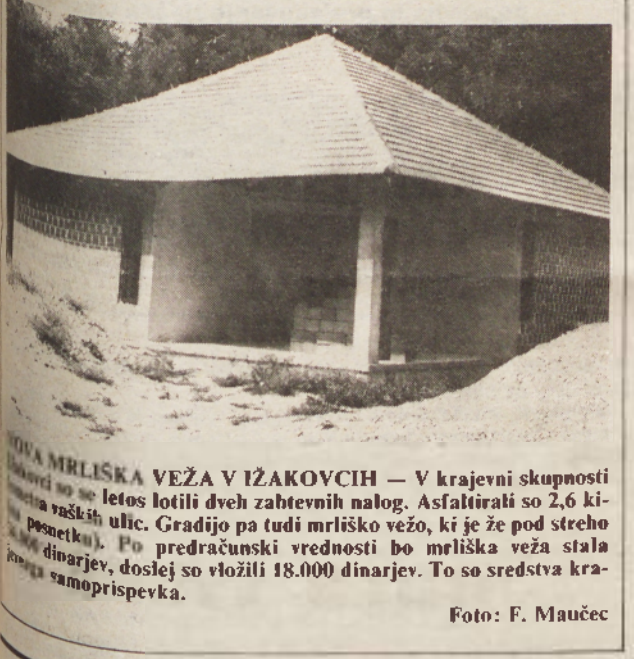
MRLIŠKA VEŽA V IŽAKOVCIH — V krajevni skupnosti letos lotili dveh zahtevnih nalog. Asfaltirali so 2,6 kilometra naših ulic. Gradijo pa tudi mrliško vežo, ki je že pod streho (posnetku). Po predračunski vrednosti bo mrliška veža stala 100.000 dinarjev, doslej so vložili 18.000 dinarjev. To so sredstva krajevskega samoprispevka.
