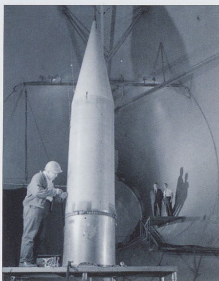
Raziskovalna raketa WASP med predstartnim testiranjem. Temne zaščitne trakove v bližini stabilizatorjev druge stopnje so pred poletom odstranili. Konico s senzorjem vpadnega kota so na vrh glave namestili tik pred startom.
