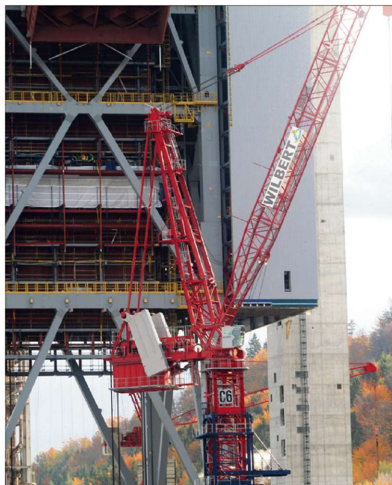
Stroji na gradbišču v Šoštanju bodo še močnejše zarohneli.
