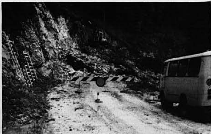
Zahtevna zemeljska dela na trasi ceste Žiri—Rovte
