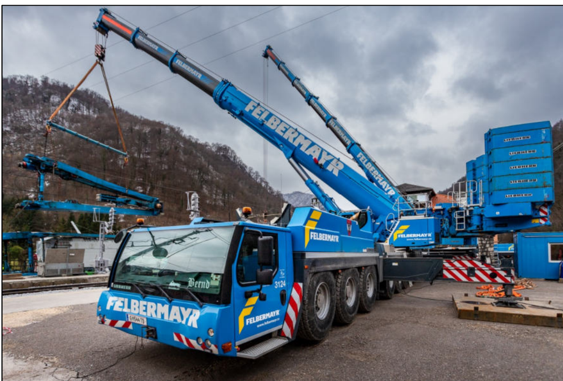
Dvig kljuna z žerjavom LTM 1450-8.1, 21. januar 2023. (Avtor: Bojan Dremelj)
