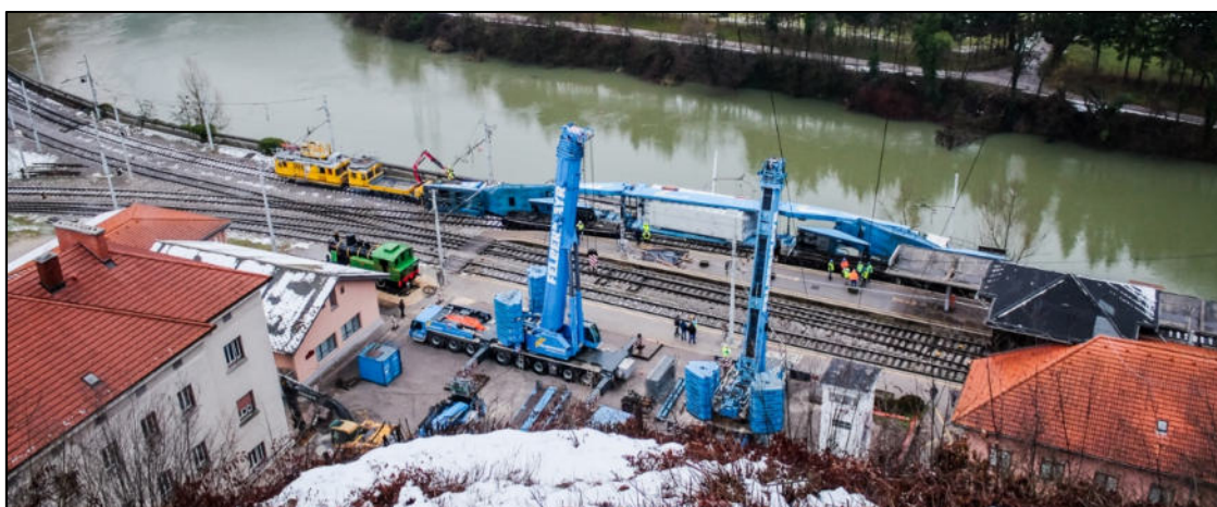
Pogled na območje sanacije, 19. januar 2023. (Avtor: Bojan Dremelj)
