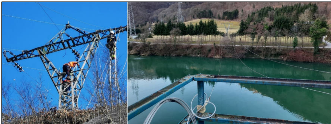
Odstranjevanje vodnikov 20 kV daljnovoda, 2. februar 2023. (Avtor: Metal Industry - Facebook in mag. Klemen Ponikvar)
