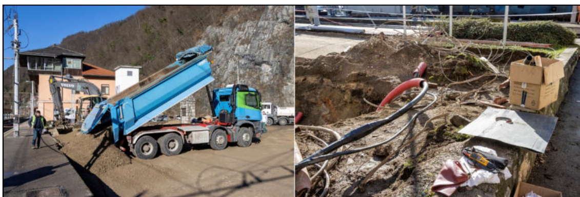
Nasipavanje tampona in urejanje podzemnih vodov, 14. januar 2023. (Avtor: Miško Kranjec)
