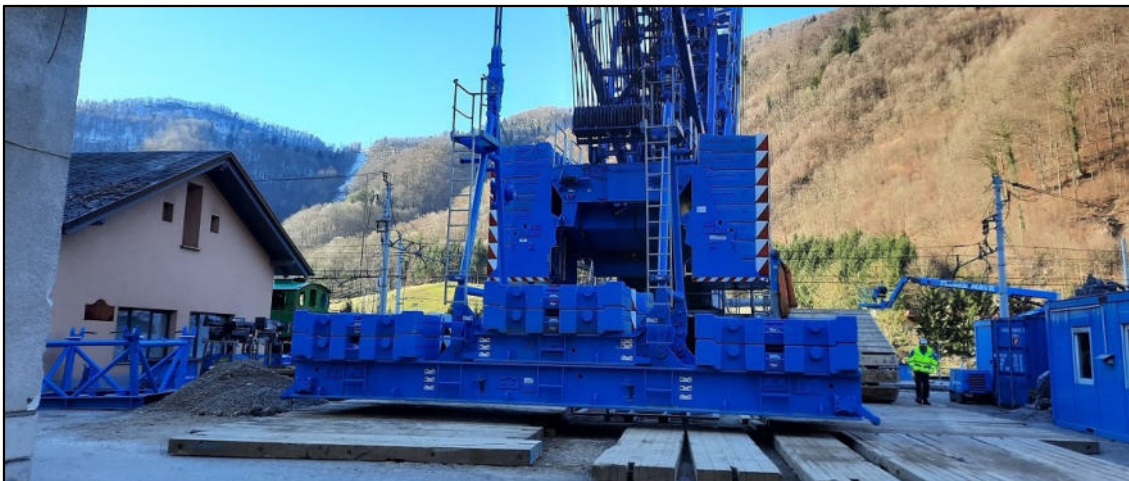
Viseča protiutež z maso ~140 t za rotacijo transformatorja. (Avtor: mag. Klemen Ponikvar)
