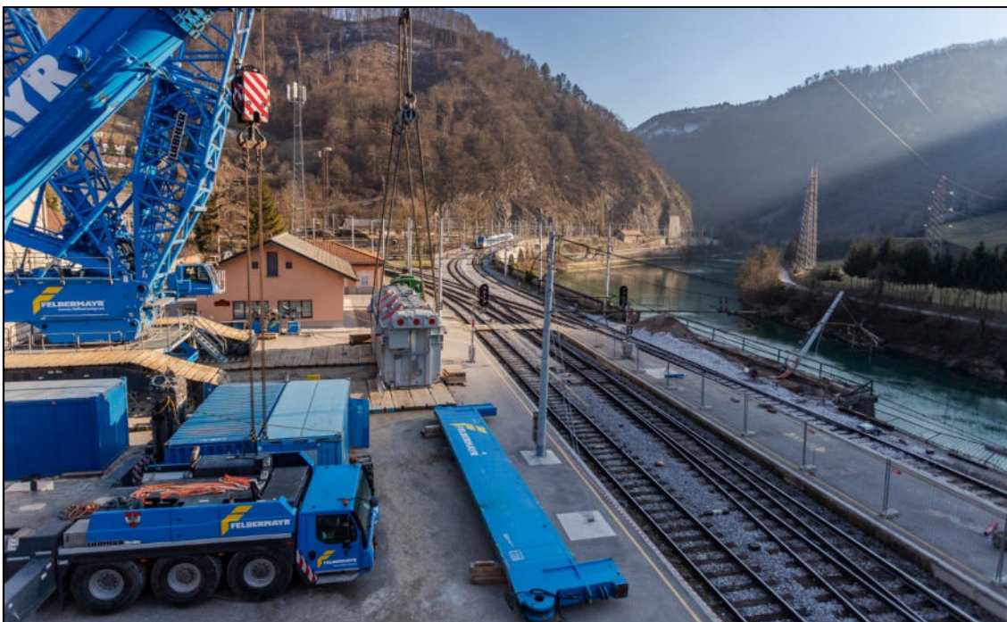
Pogled s centralne postavljalnice Zidani Most, 9. februar 2023. (Avtor: Bojan Dremelj)
