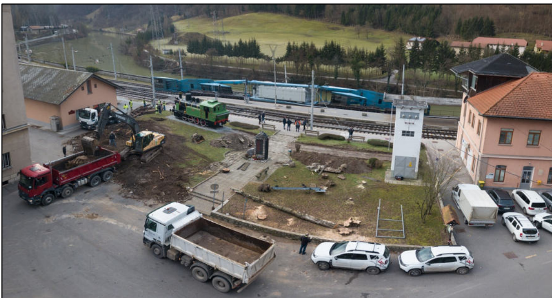
Urejanje delovne ploščadi za žerjave, 11. januar 2023. (Avtor: Bojan Dremelj)
