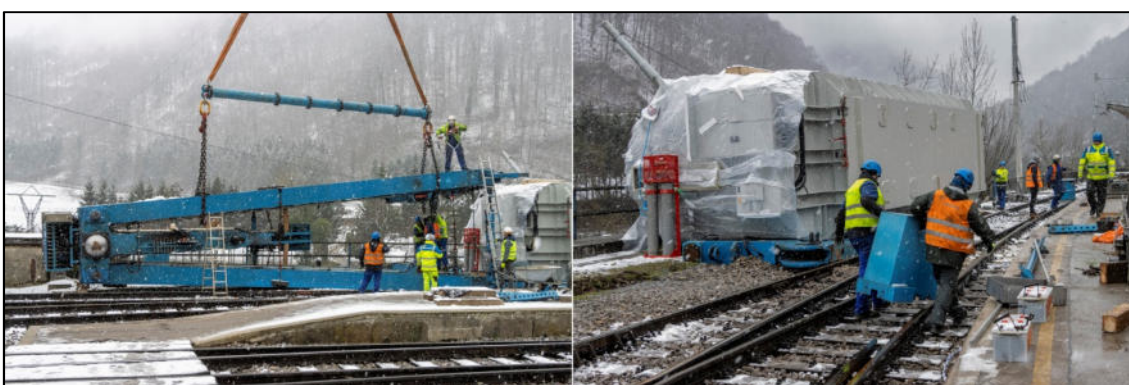
Zaključek dvigovanja vagona Uaai, 22. januar 2023. (Avtor: Miško Kranjec)
