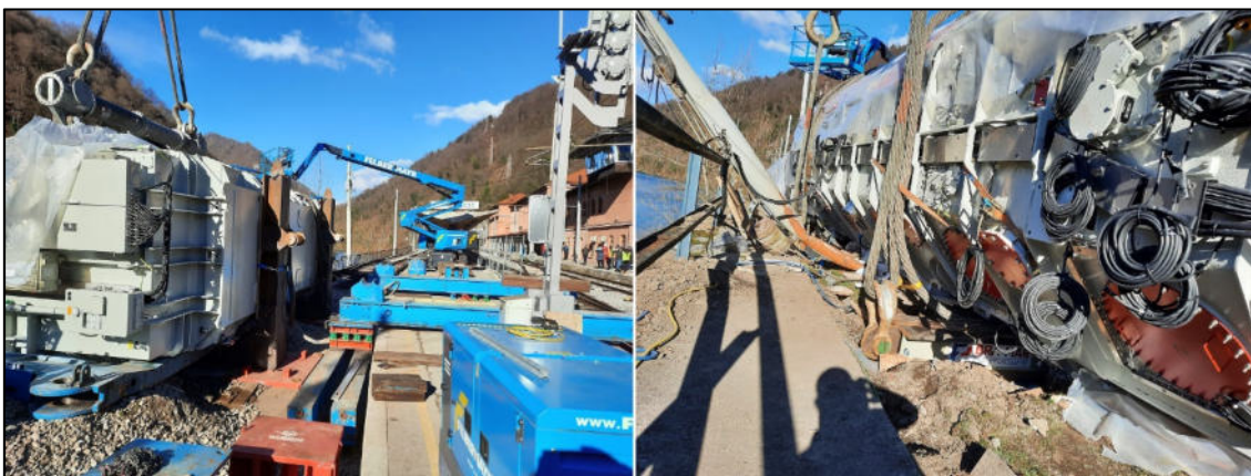
Priprava za rotacijo in dvig na posebne nosilce, 4. februar 2023. (Avtor: mag. Klemen Ponikvar)
