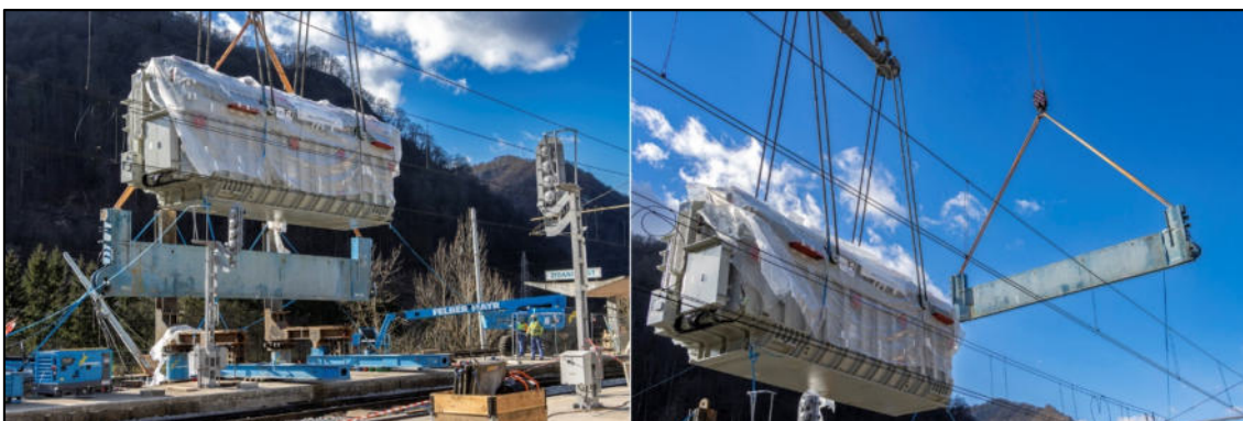
Ločeno dvigovanje transformatorja in stranice vagona, 4. februar 2023. (Avtor: Miško Kranjec)
