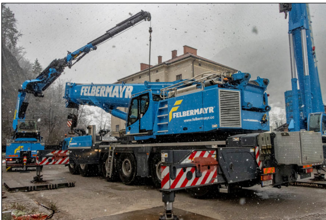
Postavljanje kolesnega žerjava LTM 1350-6.1, 19. januar 2023. (Avtor: Miško Kranjec)
