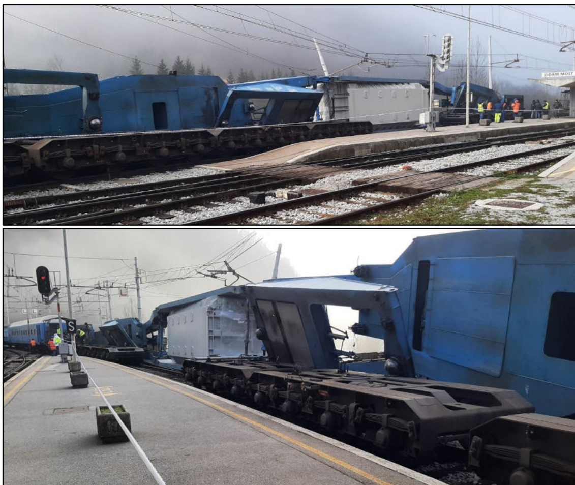
Posledice izrednega dogodka v Zidanem Mostu, 7. januar 2023. (Avtor: Matjaž Lukner)
