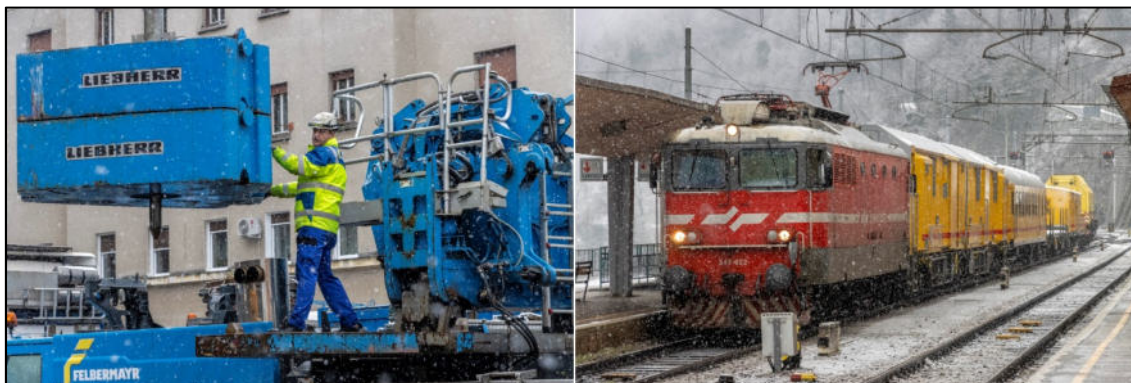
Nameščanje protiuteži in intervencijski vlak, 19. januar 2023. (Avtor: Miško Kranjec)
