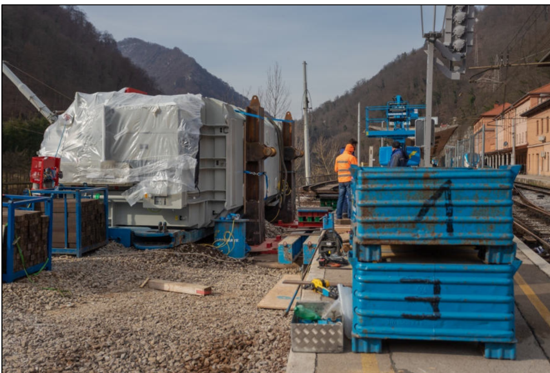
Postavitev jeklenih 'L' profilov za dvig transformatorja, 3. februar 2023. (Avtor: Bojan Dremelj)
