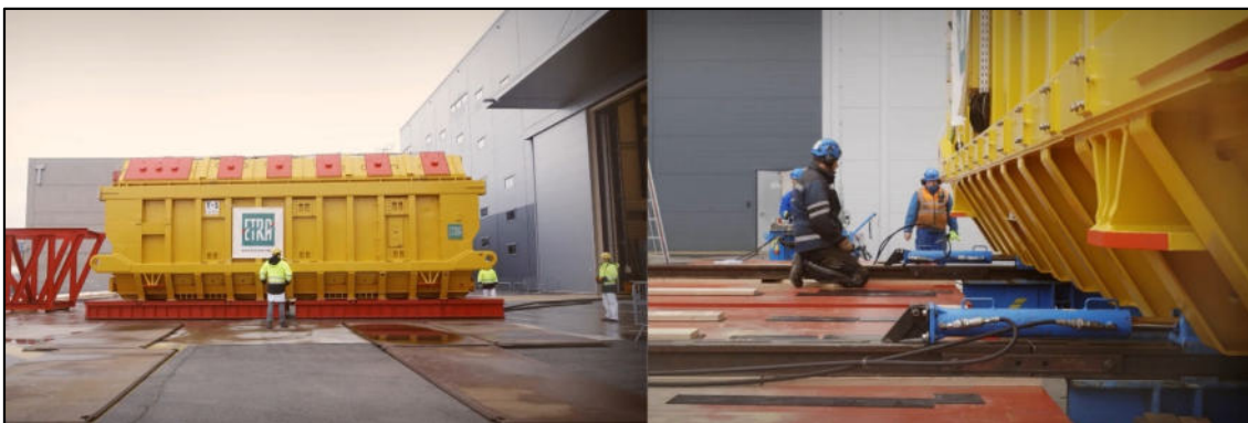
Premik velikih transformatorjev v Črnučah. (Vir: Kolektor ETRA, https://www.youtube.com/watch?v=x5BjTrfkmuE )
