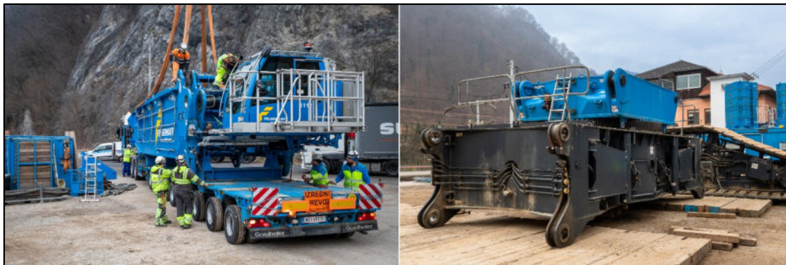
Razstavljanje žerjavnice, 23. februar 2023. (Avtor: Bojan Dremelj)
