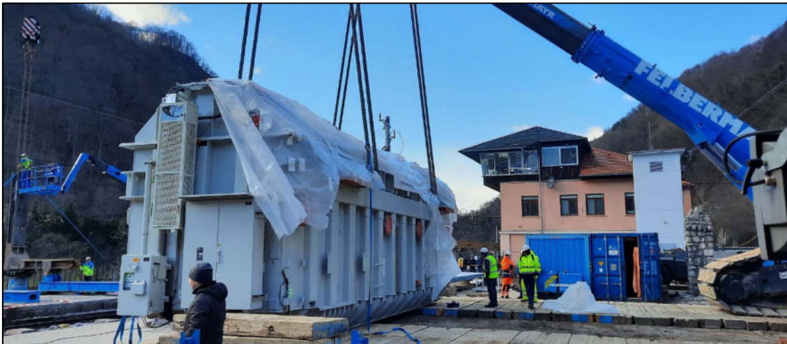
Transformator varno postavljen na ploščad, 4. februar 2023. (Avtor: mag. Klemen Ponikvar)
