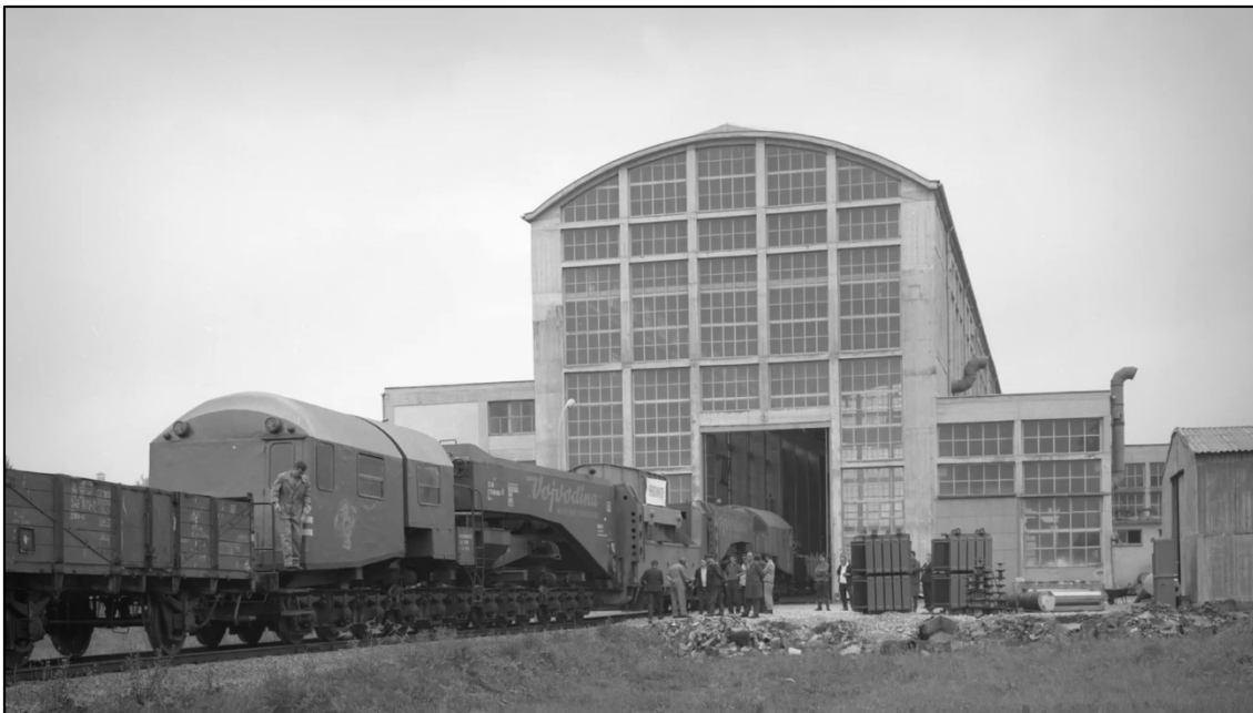
24-osni vagon s transformatorjem mase 112 t v Črnučah leta 1969. (Vir: Kolektor ETRA, https://www.youtube.com/watch?v=x5BjTrfkmuE )
