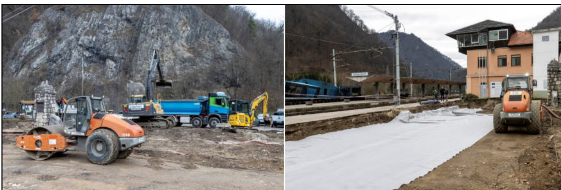
Gradbena dela za pripravo delovne ploščadi, 13. januar 2023. (Avtor: Miško Kranjec)
