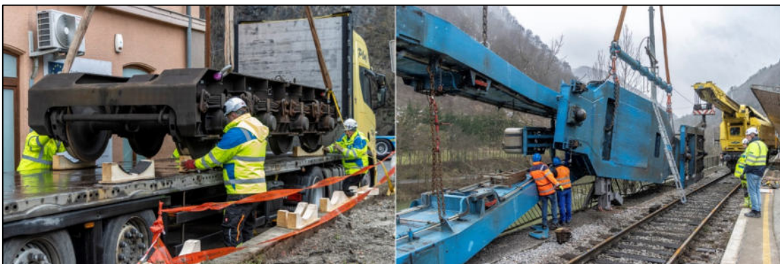
Nakladanje podstavnega vozička in dvig nosilnega mostu, 20. januar 2023. (Avtor: Miško Kranjec)
