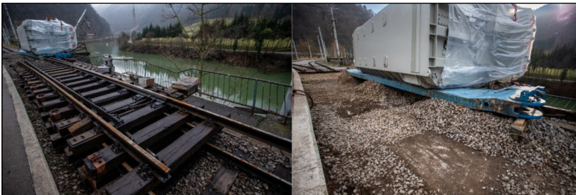
Prestavljena kretnica št. 14 in izkop tirne grede, 25. in 28. januar 2023. (Avtor: Bojan Dremelj)
