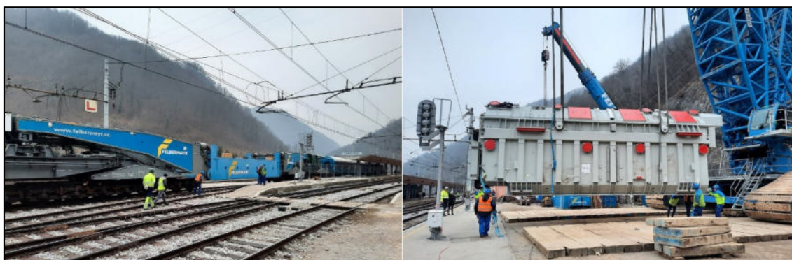
Priprava vagona in obračanje transformatorja, 18. februar 2023. (Avtor: mag. Klemen Ponikvar)
