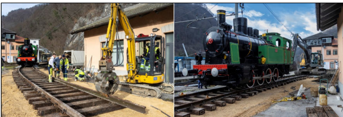
Sestavljanje tira in premik lokomotive SH-1, 12. januar 2023. (Avtor: Miško Kranjec)
