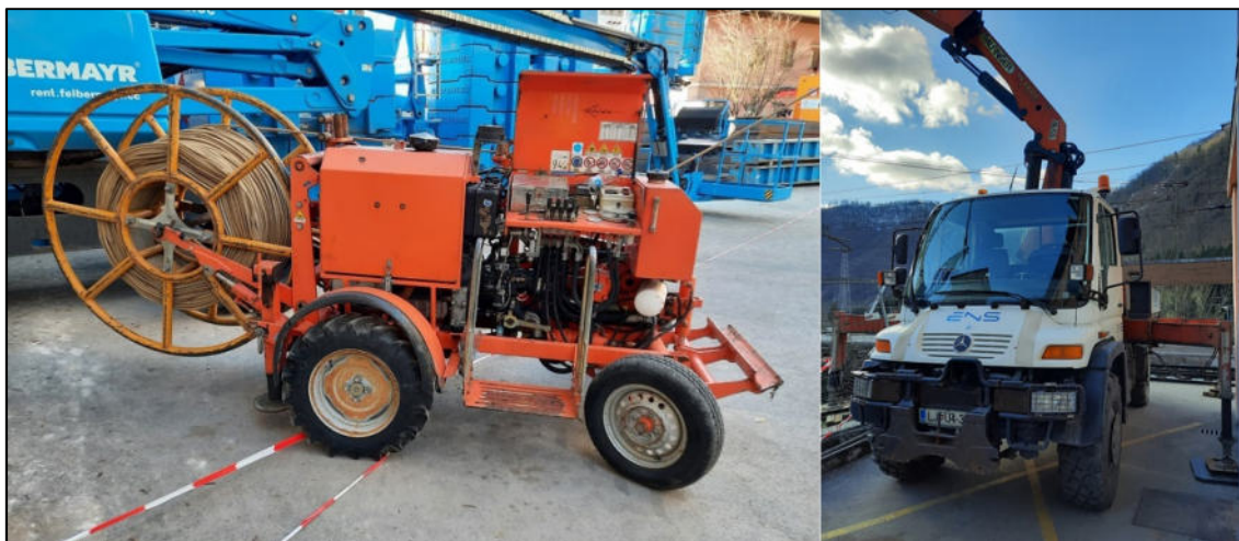
Vlečni vitel in UNIMOG med nameščanjem daljnovoda, 5. februar 2023. (Avtor: mag. Klemen Ponikvar)
