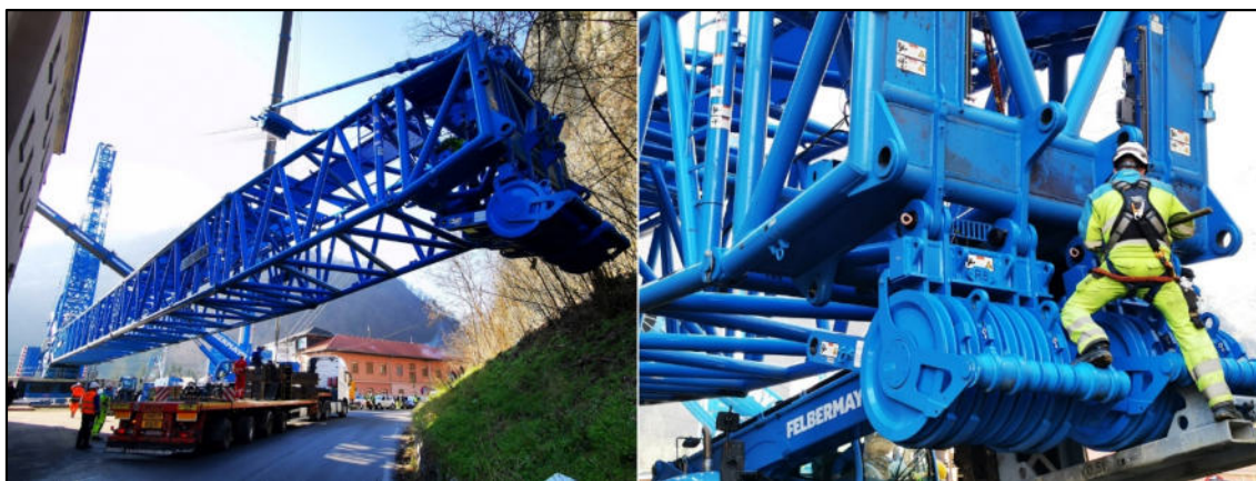
Sestavljanje glavnega kraka žerjava, 2. februar 2023. (Avtor: Metal Industry - Facebook)
