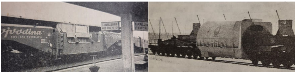
Transformator v Ljubljani 1969 in generator pri Žalcu 1977. (Vir: Radivoj Pleterski, Nova proga 1969 in 1977)
