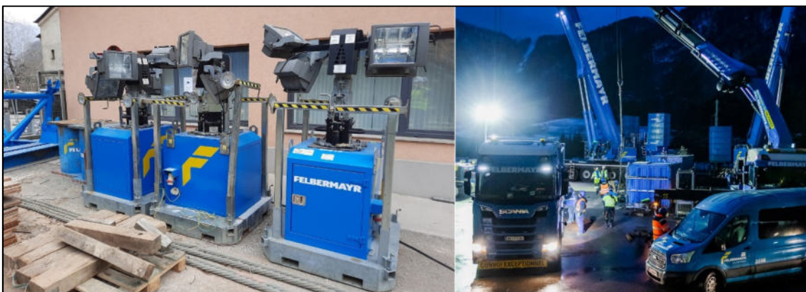
Reflektorji in osvetljevanje delovne ploščadi v večernem času. (Avtorja: mag. Klemen Ponikvar in Bojan Dremelj)
