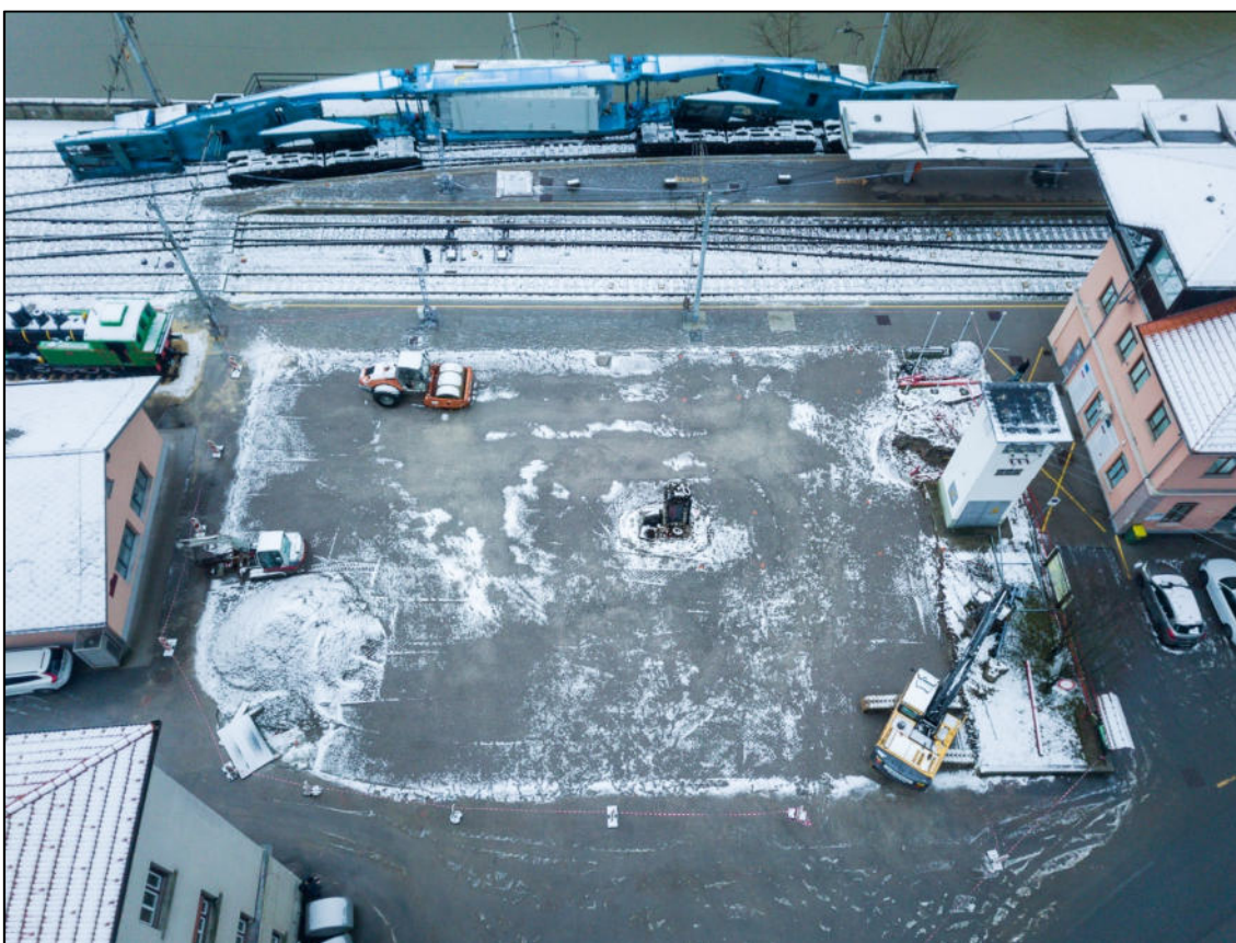
Pripravljena delovna ploščad, 16. januar 2023. (Avtor: Bojan Dremelj)
