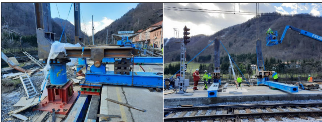
Nosilna konstrukcija po dvigu transformatorja, 4. februar 2023. (Avtor: mag. Klemen Ponikvar)
