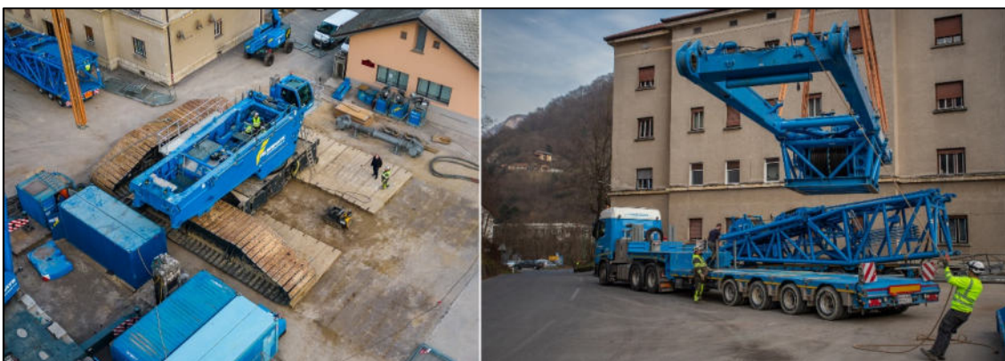
Razstavljanje žerjava, 22. februar 2023. (Avtor: Bojan Dremelj)
