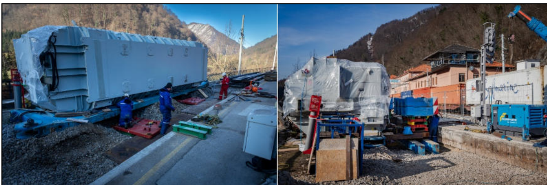
Priprava podlage za transformator, 31. januar in 1. februar 2023. (Avtor: Bojan Dremelj)
