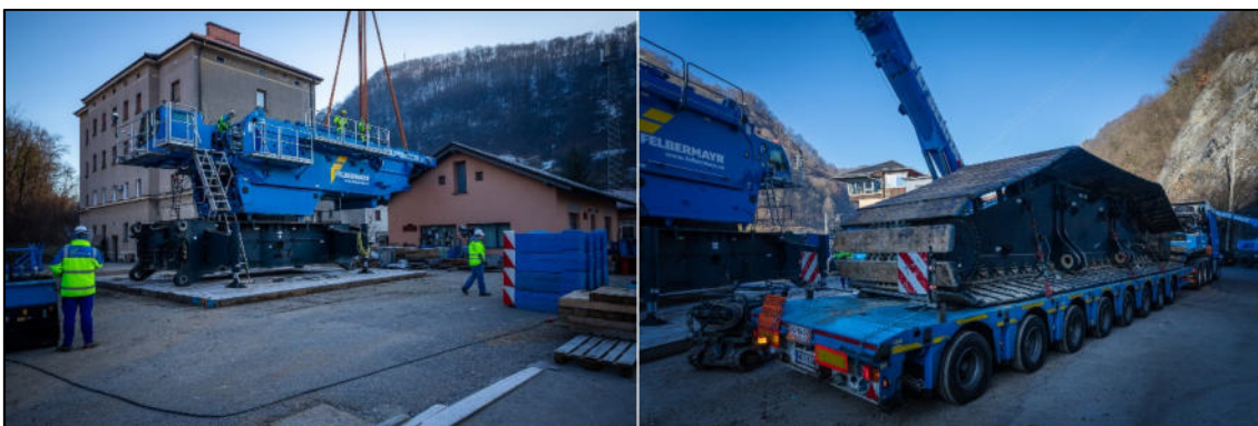
Sestavljanje žerjava po sklopih, 31. januar 2023. (Avtor: Bojan Dremelj)
