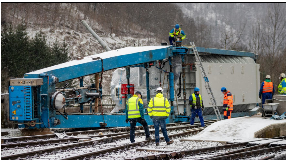
Ločevanje zgornje nosilne stranice od kljuna, 22. januar 2023. (Avtor: Bojan Dremelj)
