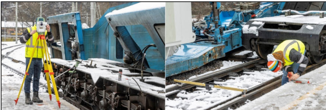
Geometrijske meritve kretnice št. 14 v Zidanem Mostu, 16. januar 2023. (Avtor: Miško Kranjec)
