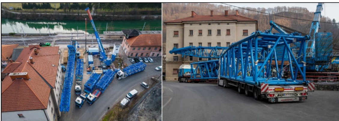
Razstavljanje nosilnega kraka, 21. februar 2023. (Avtor: Bojan Dremelj)
