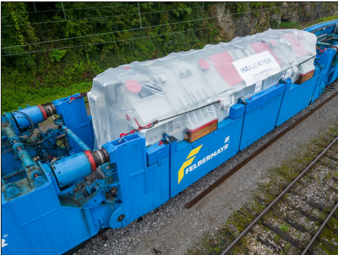
Nesrečni transformator št. 6 še drugič na postaji Zidani Most, 20. oktober 2023. (Avtor: Bojan Dremelj)
