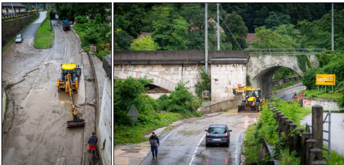
Čiščenje poplavljenih cest v Zidanem Mostu, 6. avgust 2023. (Avtor: Bojan Dremelj)
