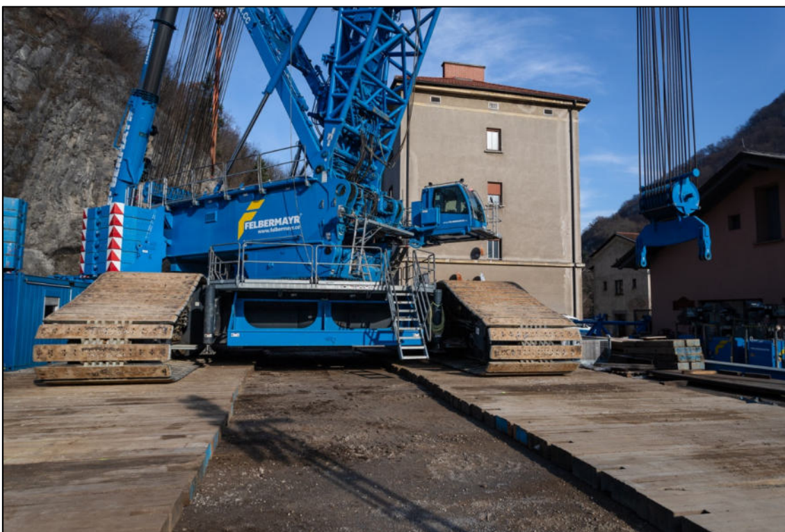
Žerjav LR 11000 še brez glavnega nosilnega kraka, 1. februar 2023. (Avtor: Bojan Dremelj)
