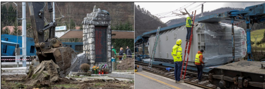
Zemeljska dela in pregled transformatorja, 11. januar 2023. (Avtor: Miško Kranjec)
