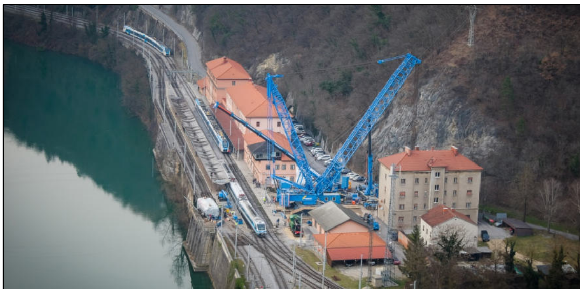
Dvignjen nosilni krak žerjava LR 11000, 2. februar 2023. (Avtor: Bojan Dremelj)
