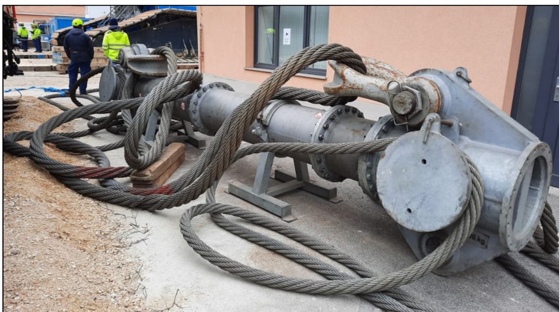
Vzdolžni razporni drog. (Avtor: mag. Klemen Ponikvar)
