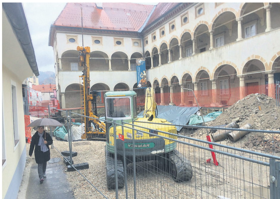
Do konca leta bo na tem mestu, na vzhodni strani Muzejskega trga, pred Staro grofijo, zgrajen objekt za zaščito dragocenih fresk.
