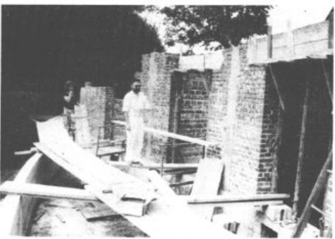
Katica in Branko Caglič na gradbišču svoje bioklimatske hiše pred tremi tedni
