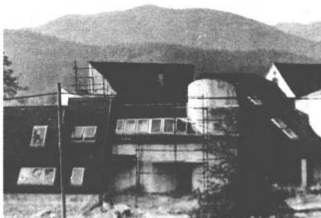
Izgradnja novega kulturnega hrama hitro napreduje
