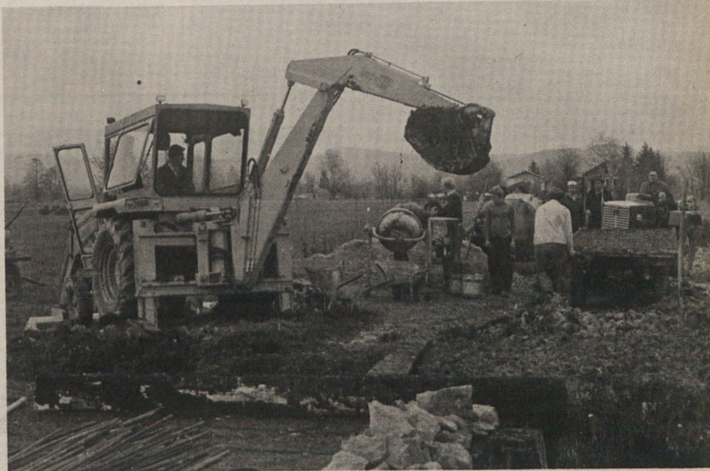
— Prostovoljno udarniško delo na mostu čez Farjevca v Kozlarjevi gošči
