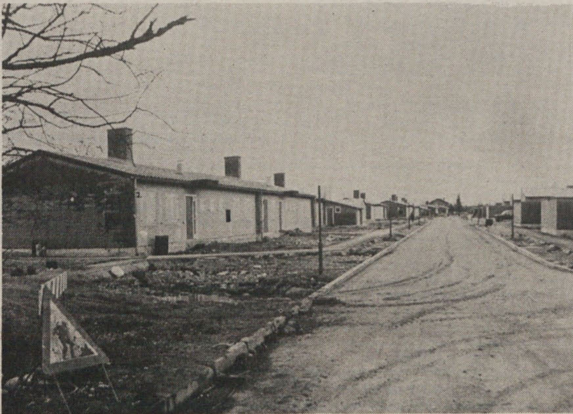
Gradnja v Murglah
