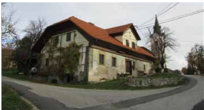
Delno obnovljena Bančeva hiša sredi vasi
