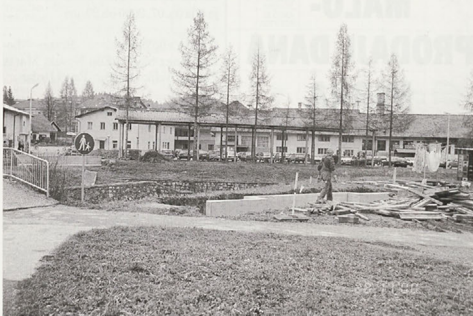
Temelji bodočega mostu za ureditev obvoznice.
