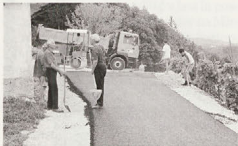
Polaganje asfalta na cesti pri Bevčevi (Janežičevi) hiši na Debencu.
