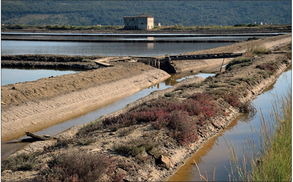
Slika 2: Temeljne prvine solin so solna polja z bazeni, kanali s spremljajočimi nasipi in potmi ter solinarske hiše, mostovi, zapornice in črpalke.
