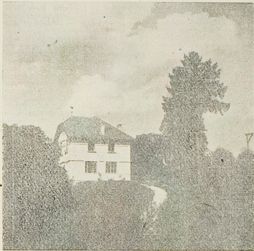
Poslopje osnovne šole v Šebreljah, ki je bilo ob letošnjih počitnicah prenovljeno znotraj in zunaj
