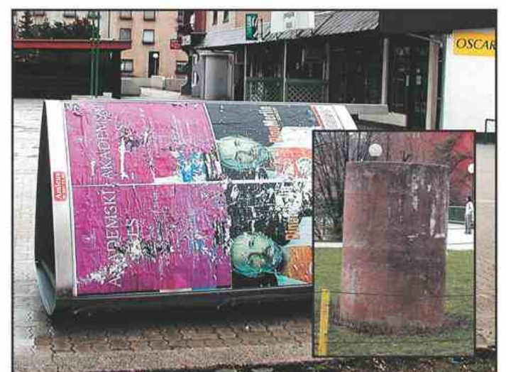
Kovinski panoji niso odporni proti vetru. Na Kardeljevem trgu so že vrnili starega - betonskega.
